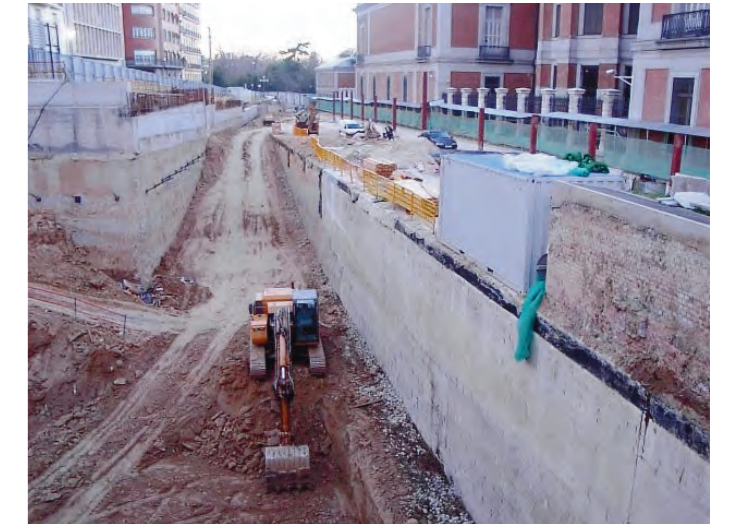
Inicio excavación de la zona de vestíbulo.
