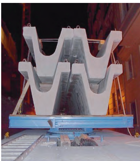
Transporte de vigas prefensadas de la cubierta del auditorio.
