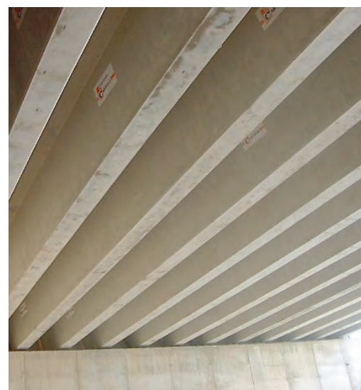
Vista inferior de las vigas de la cubierta.
