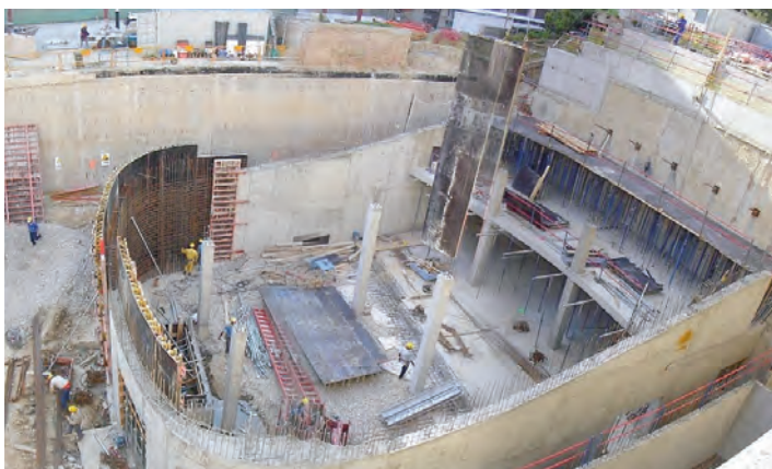
Panorámica del auditorio antes de la ejecución del graderío.
