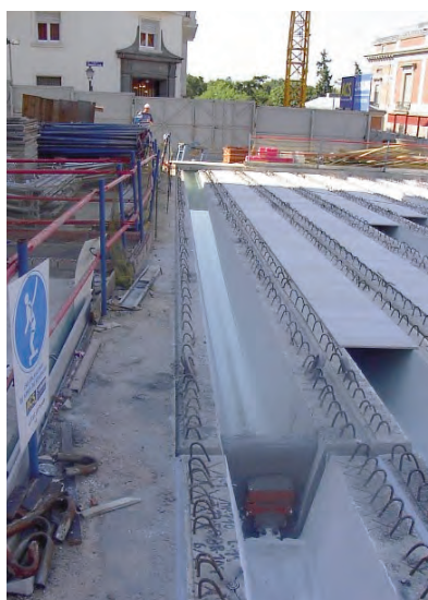
Detalle de montaje de prelasas sobre las vigas de cubierta.
