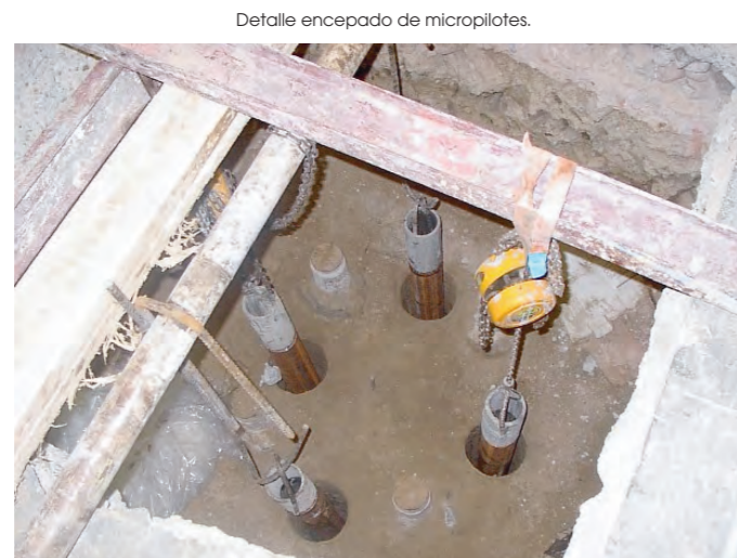
Detalle encapado de micropilotes.
