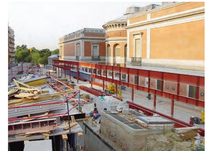
Montaje del pórtico metálico de la fachada interior de la zona de vestíbulo.
