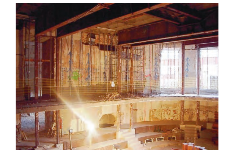
Vista de las vigas de cubierta originales, pilares metálicos y entreplanta.
