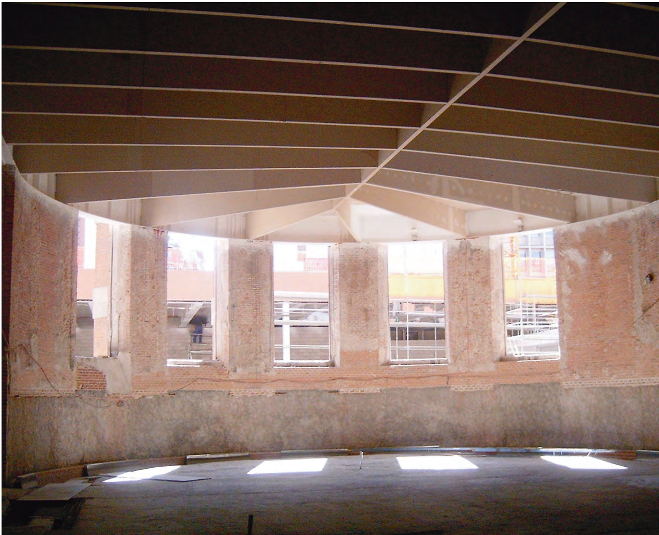
Ábside terminado el refuerzo de estructura.
