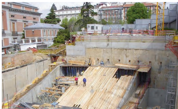
Encofrado de la losa de graderío del auditorio.
