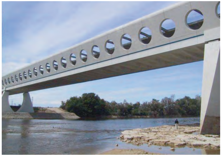
Puente de Osera del Ebro - Línea de Alta Velocidad ferroviaria Madrid-Barcelona.
