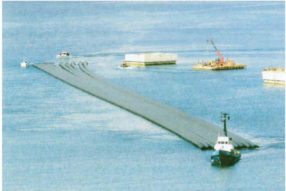
do, que aprovechando la curvatura que admite la tubería (> 50 veces del diámetro), hace que no sea preciso apoyar la conducción sobre un pe-draplén de escollera.
