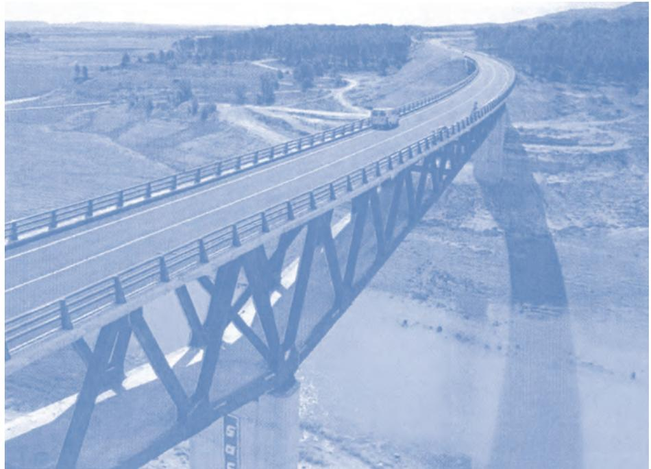
embalse de Buendía, pues influye decisivamente en el diseño de la estructura y en su proceso constructivo, que en este caso están íntimamente ligados. La luz de la estructura viene condicionada por no colocar las pilas en zona de nivel normal del embalse.
