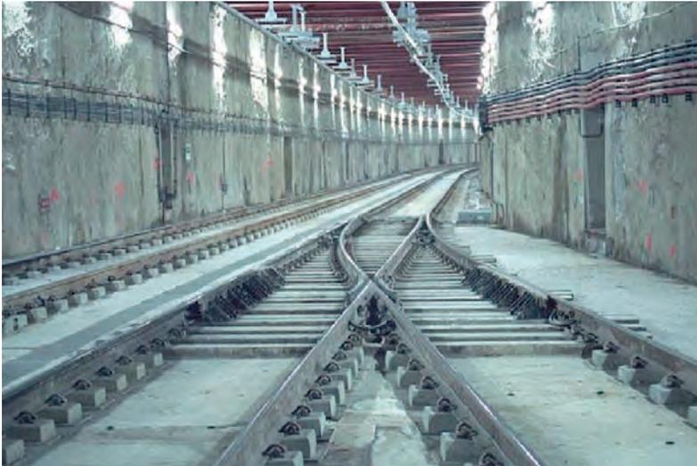
Fig.20. Aparato de vía hormigonado, sin mantenimiento, en Metro de Madrid.
