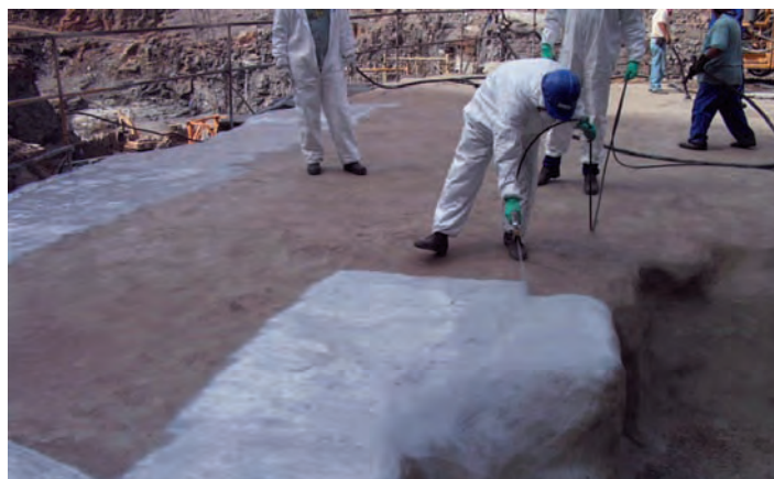
Instalación de la Manta de PEAD en el paramento de aguas abajo de la presa—protección contra las aguas de lluvia/Instalação da Manta de PEAD no paramento de jusante da barragem—proteção contra as águas de chuva.
