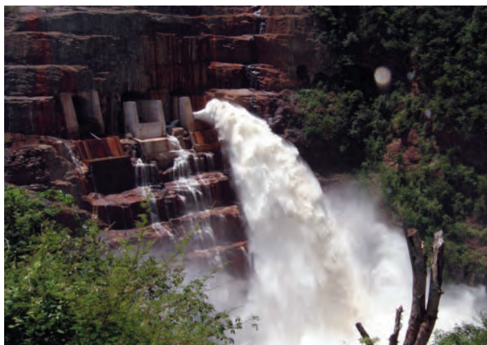
Desagüe de los túneles del aliviadero/ Desemboque dos túneis do vertedouro.
