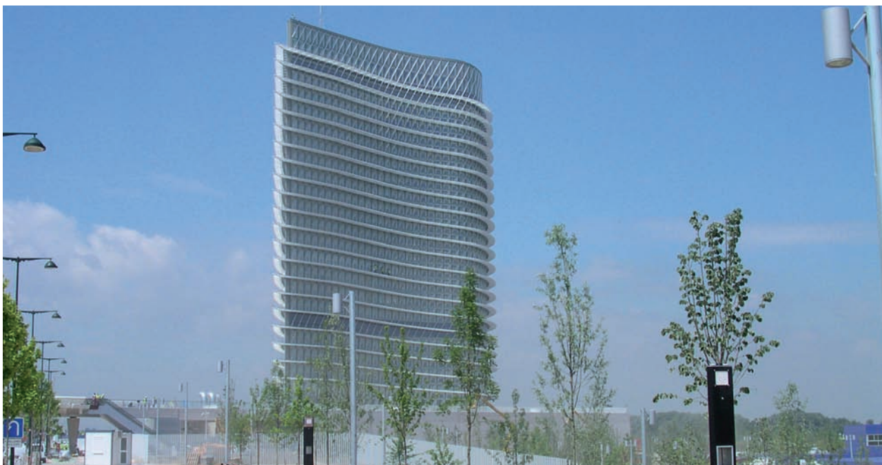
Fig. 1. Vistas generales de la Torre al final de la construcción desde diferentes puntos de vista.
