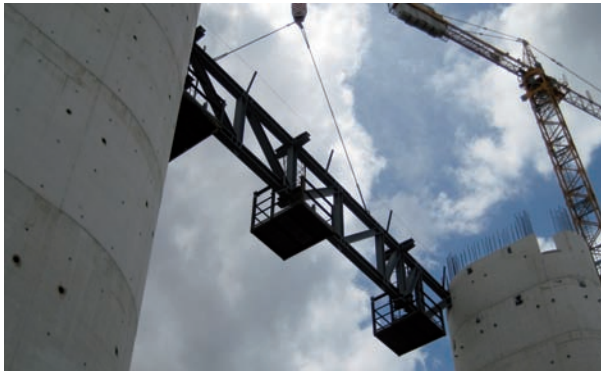
Fig.12. Diferentes vistas durante la construcción de la torre, incluyendo las grúas y plataformas empleadas para el montaje de la fachada y las plataformas intermedias, y los encofrados trepantes de los núcleos.
