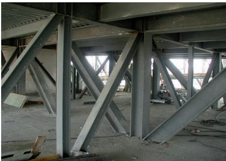
Fig. 10. Vistas de las celosías principales y de las secundarias en voladizo desde éstas: montaje de la estructura metálica y aspecto final tras la construcción de las losas superior e inferior.
