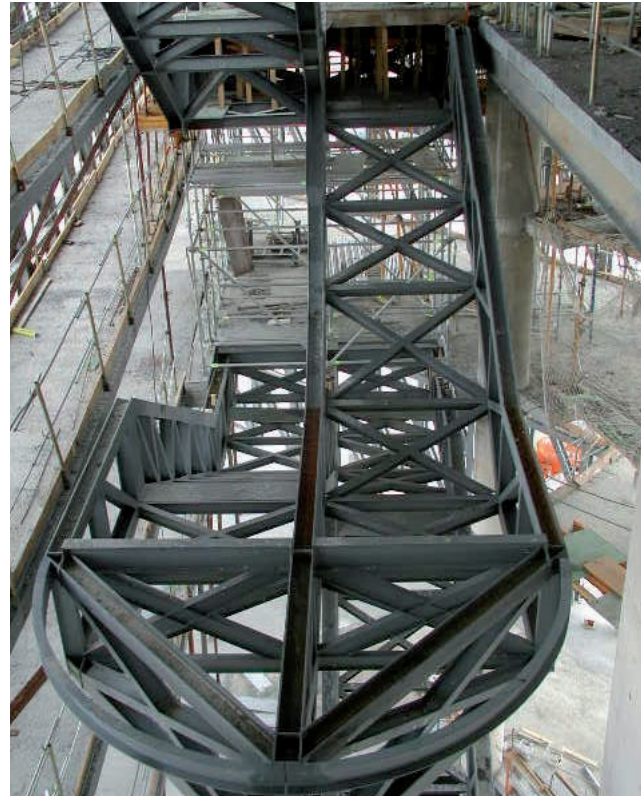
Fig. 11. Celosías espaciales en voladizo para el apoyo de las escaleras mecánicas.
