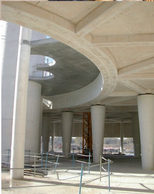
Fig. 4. Vista aérea general del forjado nervado durante su ejecución y detalle de los soportes y el remate del óculo.
