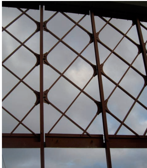
Detalle del diagrid y costillas.
