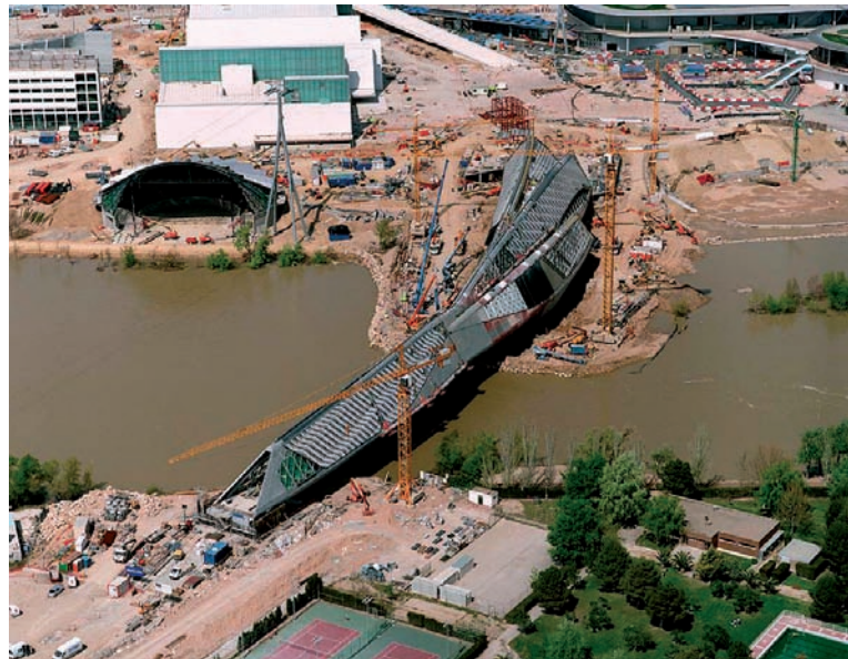
El Pabellón Puente durante su construcción.
