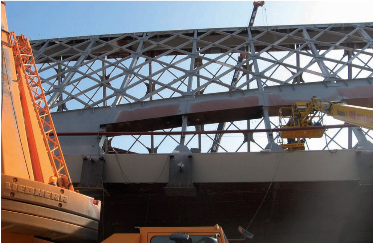
Vista lateral del diagrid y aberturas de ventanas.
