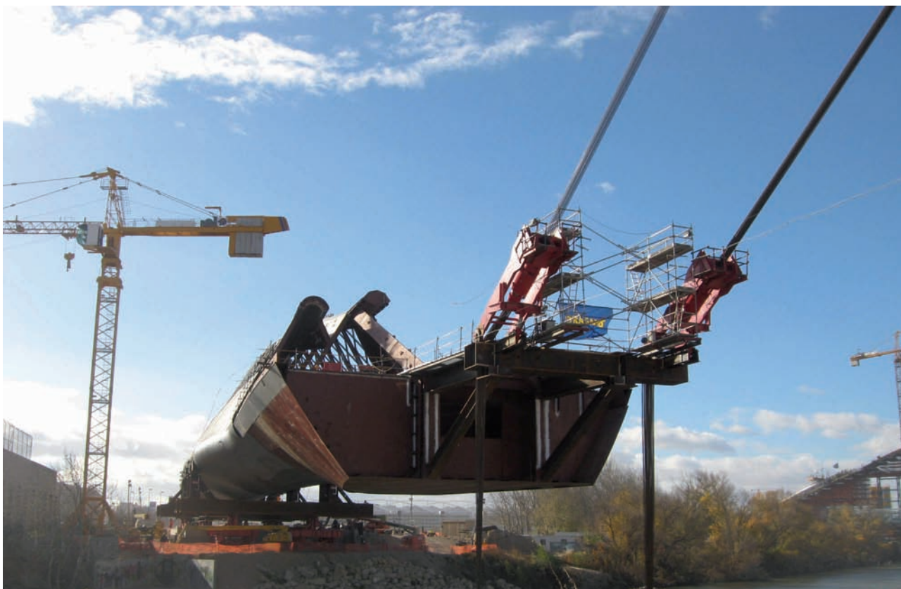
Proceso de lanzamiento del Pod 4.
