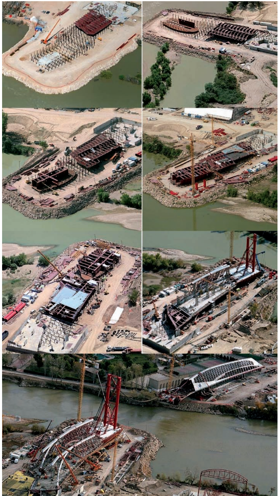
Fig. 8. Secuencia de montaje de la estructura metálica de la parte norte.
