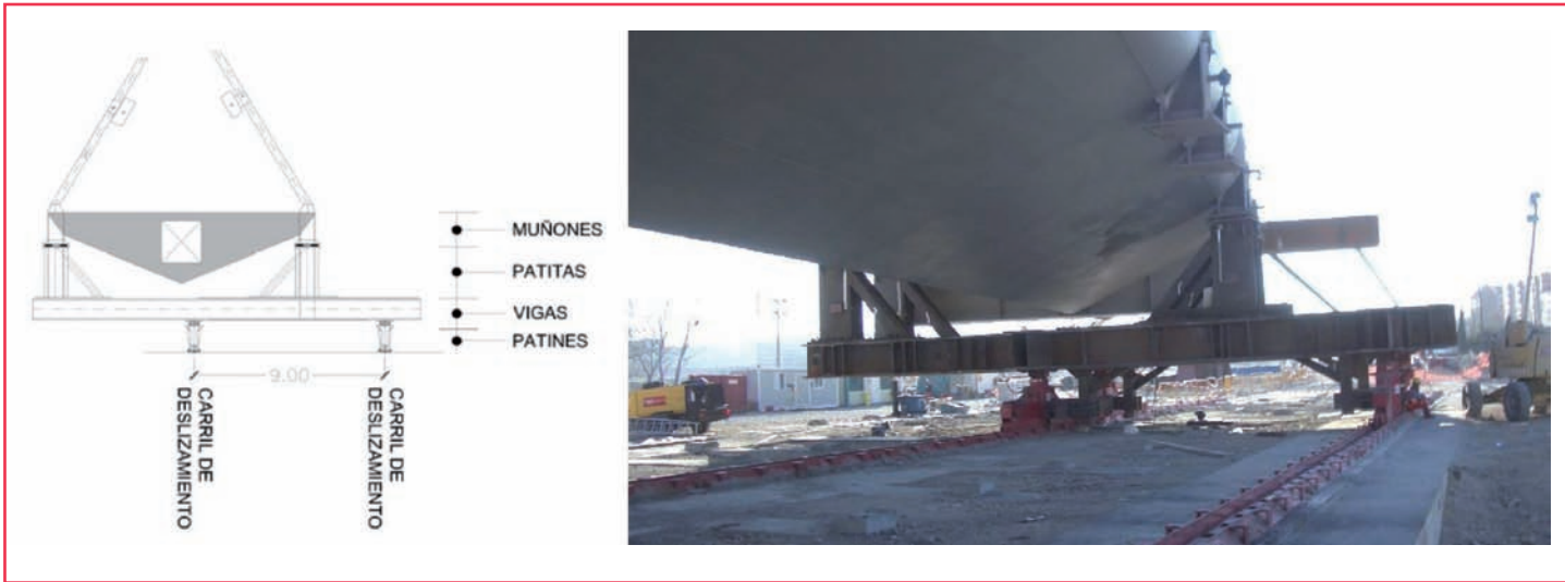
Fig. 16. Esquema apoyo de patín trasero en secciones últimas.
