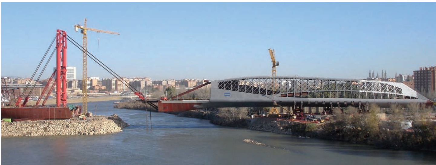
Fig. 17. Posición del puente durante una fase intermedia del proceso de lanzamiento.
