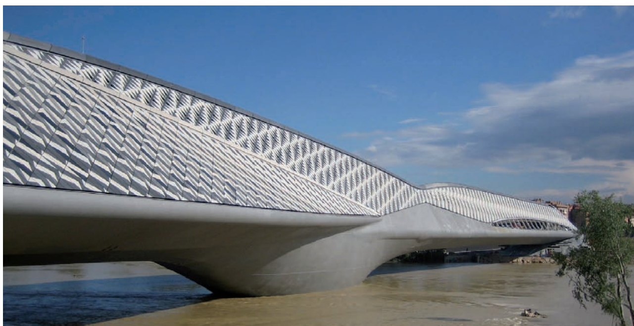
Figs. 22 y 23. Distintas vistas del pabellón puente terminado.
