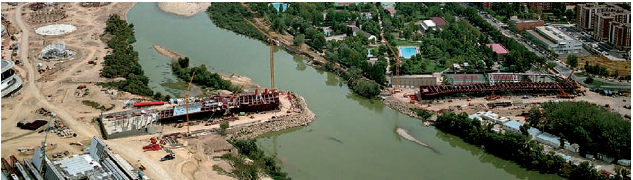
Fig. 6. Vista general del montaje de las partes: norte sobre península provisional, y sur fuera del emplazamiento definitivo para su posterior empuje.
