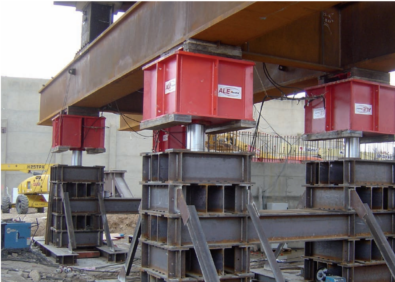
Fig.19. Estructura especial de gateo para descender el estribo sur de la parte lanzada.
