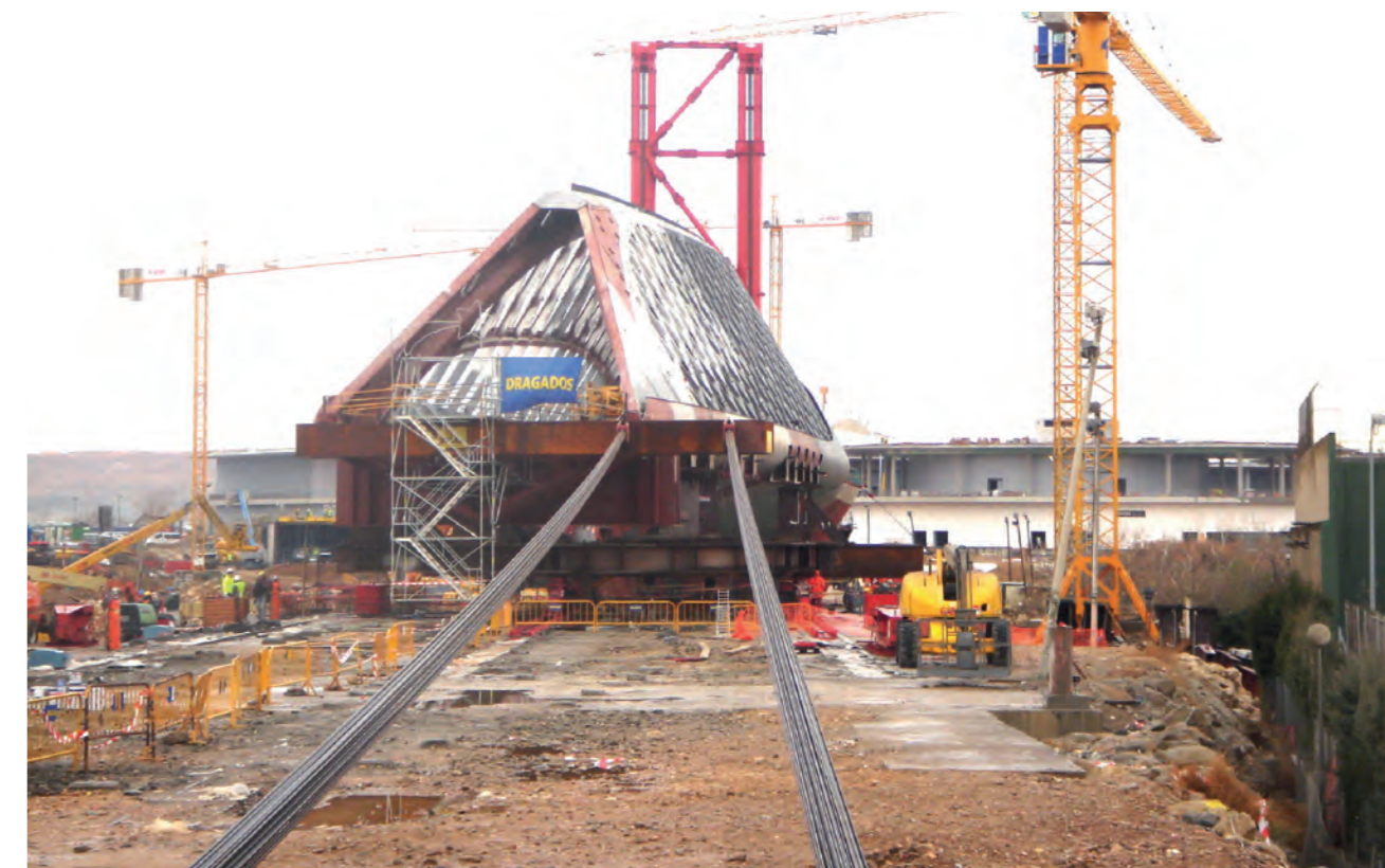
Fig. 13. Vista trasera del tramo sur durante el lanzamiento.
