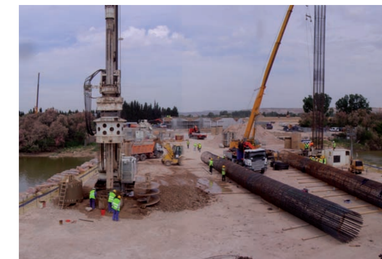
Foto 10: Cimentaciones en la península provisional de margen izquierda.
