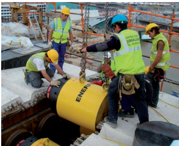
Foto 26: Colocación de uno de los seis gatos de apertura en clave en su posición final de la dovela de clave.
