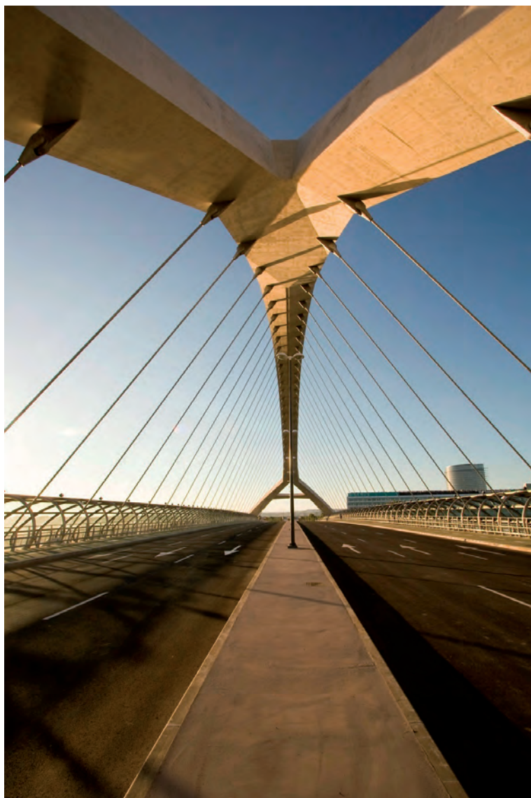
Foto 5: Vista desde debajo de arco central, nudo y pies inclinados
