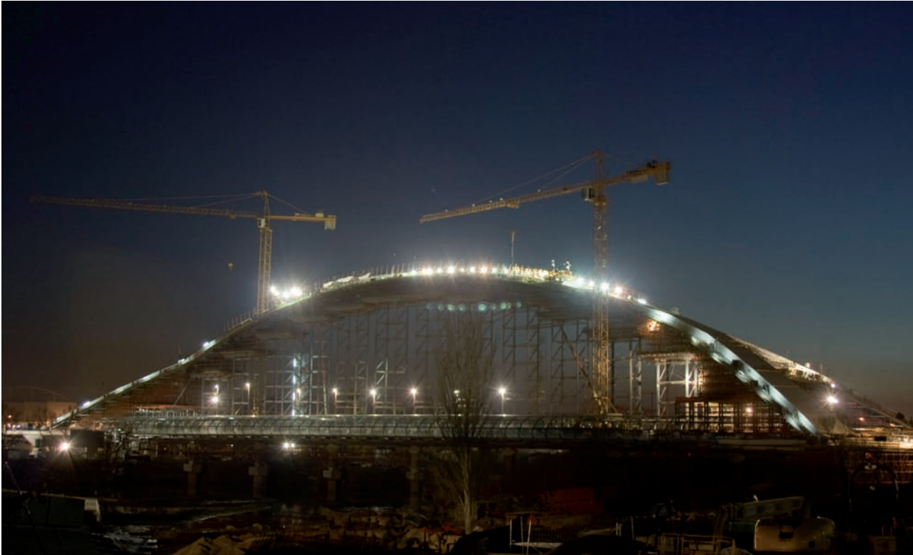
Foto 20: Vista nocturna de los trabajos sobre la cimbra
