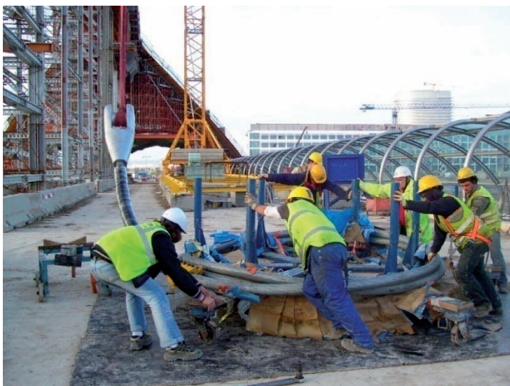
Foto 22: Desenrollado e izado de péndola
