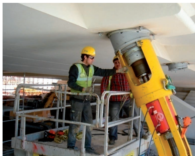
Foto 23: Gato y puente de tesado de péndola
