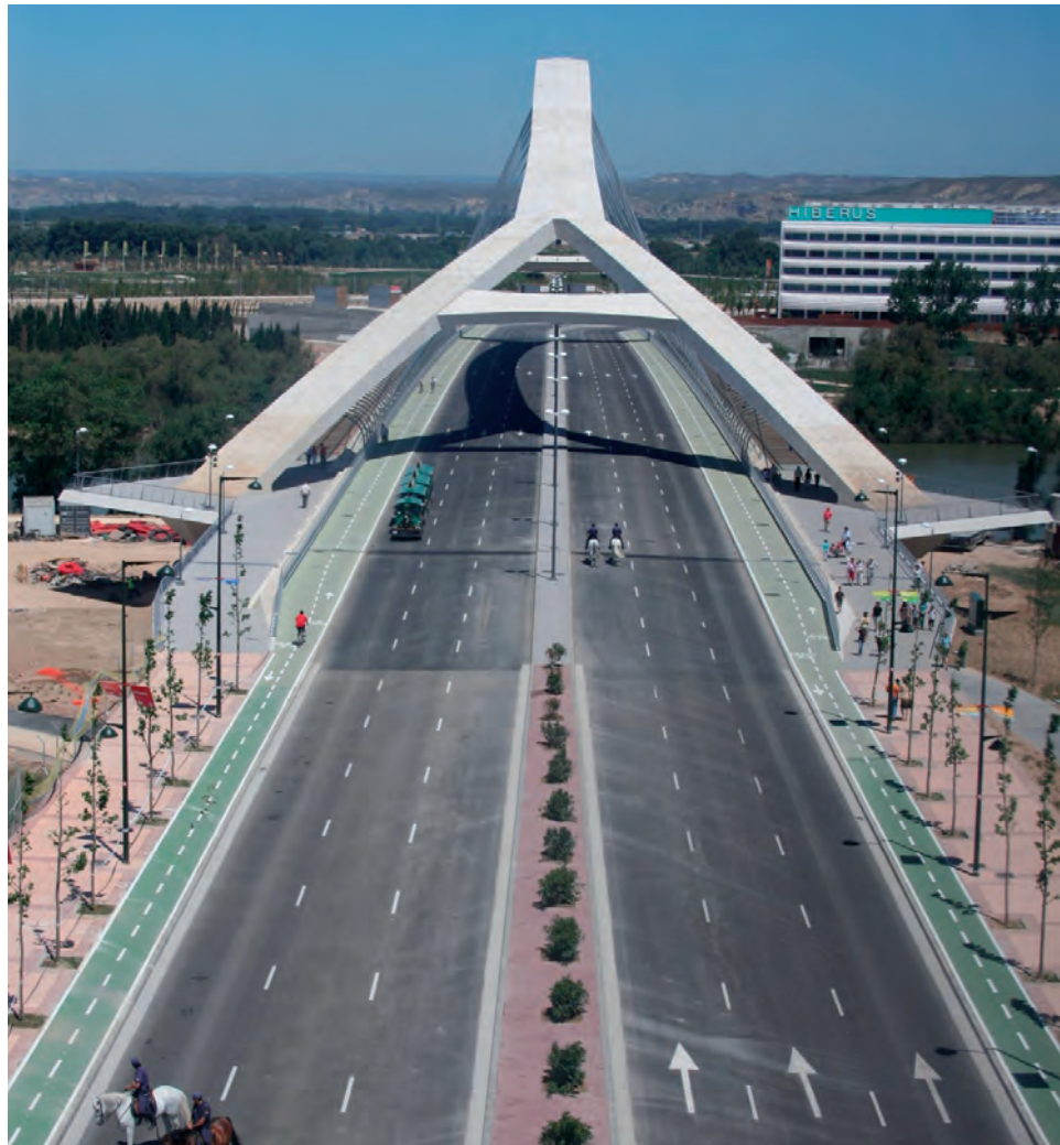
Foto 3: Vista frontal a toda anchura del puente (Foto de Miguel Daza).
