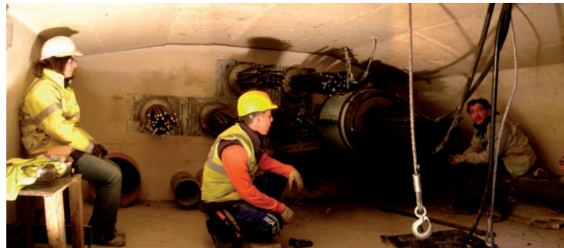
Foto 25: Operaciones de tesado del pretensado exterior en el interior de un nervio de borde
