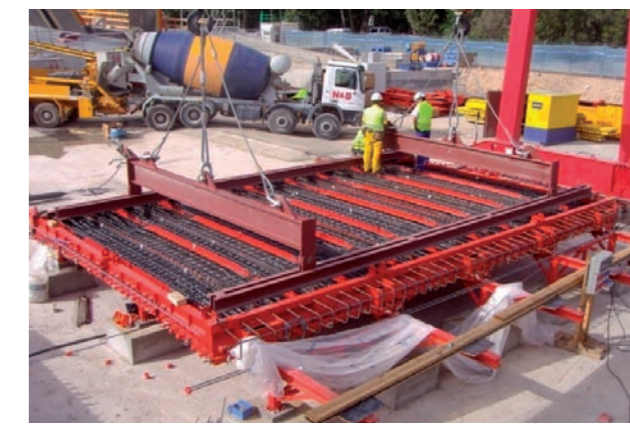
Foto 14: Vista general y detalles del parque de fabricación de prelosas y diafragmas
