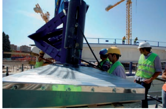
Foto 17: Vista frontal de la nariz de avance
