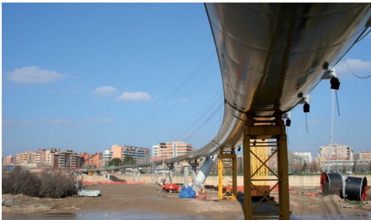
Fig. 16. Construcción. Cimbrado del dintel.
