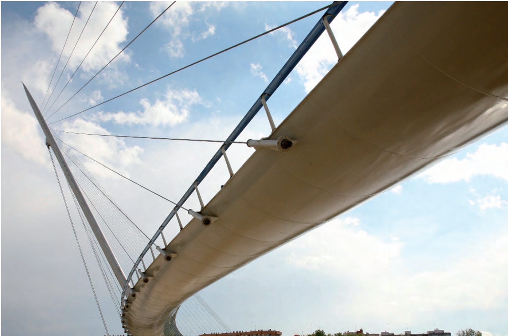
Fig.9. Vista lateral de la pasarela desde donde se aprecia la curvatura de su planta.
