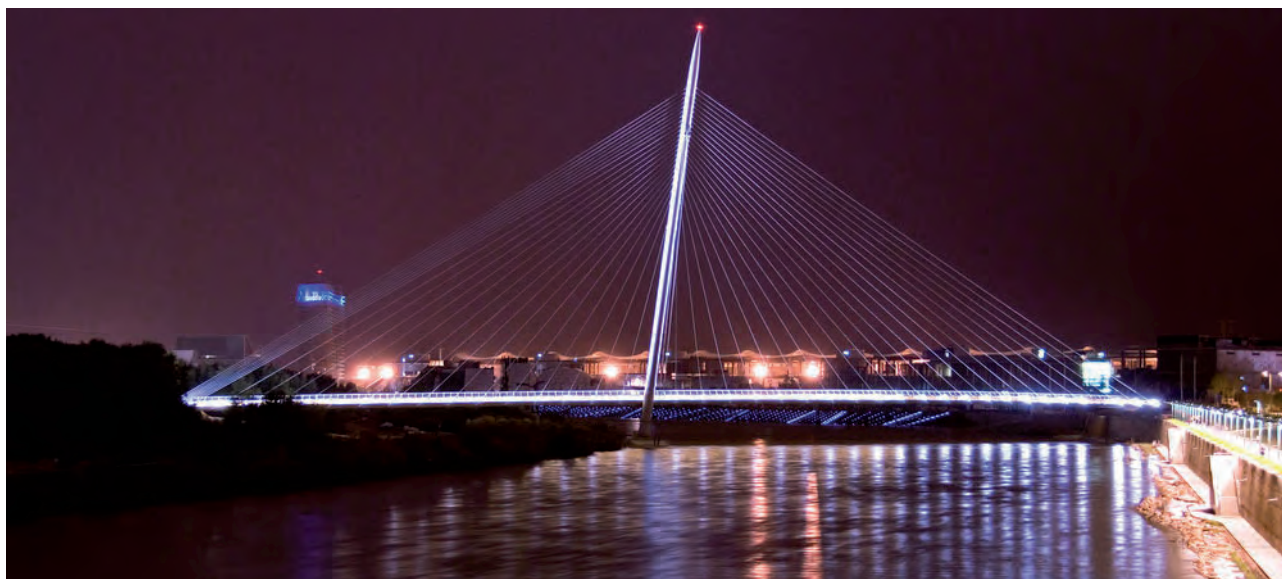
Fig 8. Vista nocturna de la pasarela del Voluntariado diseñada por el Ingeniero Javier Manterola.
