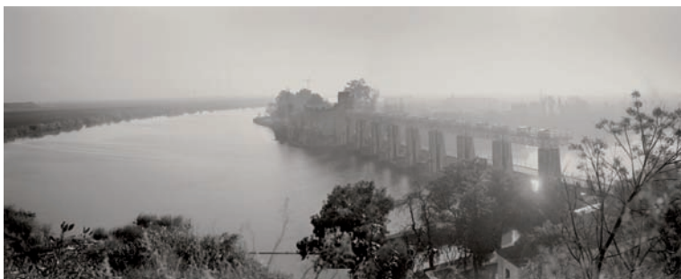
Castro Prieto. Arriba: Azud sobre el Alberche en Navaluenga. Abajo: Presa de Alcalá del Río sobre el río Guadalquivir.
