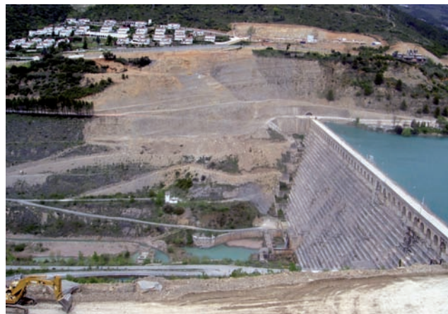
Foto 6. Presa de Yesa.
