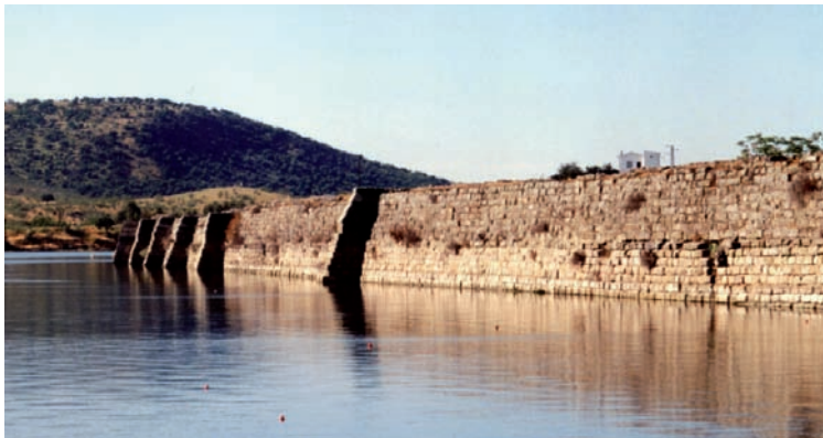
Foto 1. Vista de la Presa de Proserpina.
