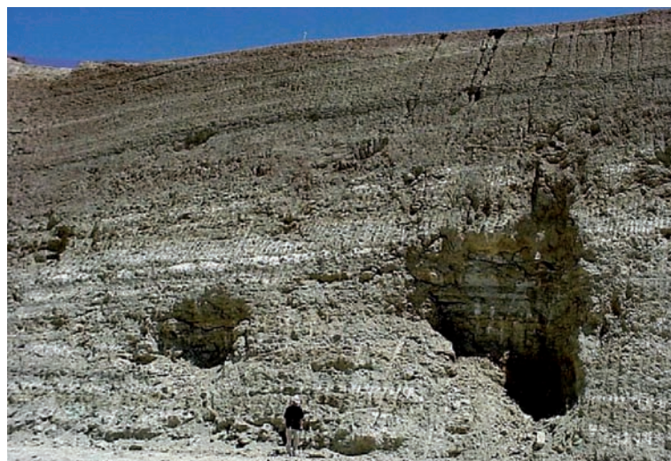
Fig. 3. Imagen del talud de excavación para el apoyo de una presa sobre una formación yesífera.
