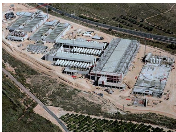
Fig. 6. Planta desaladora de Torreveja (septiembre 2008).
