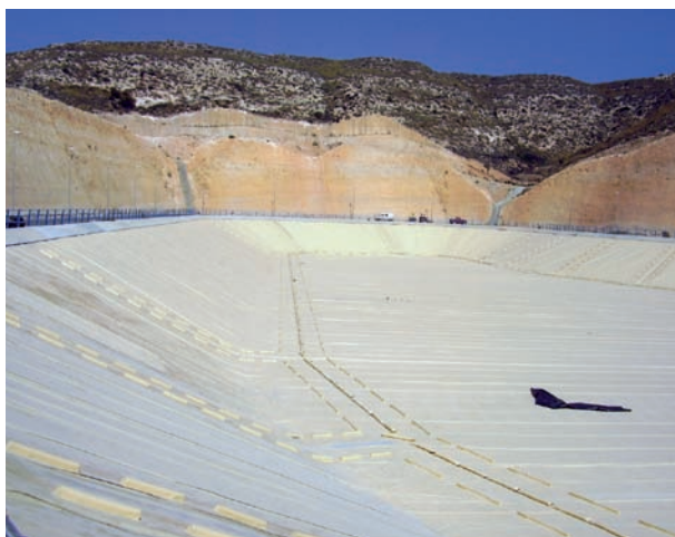
Fig. 2. Balsa de Carboneras. Se está cubriendo para permitir su uso para agua de abastecimiento.
