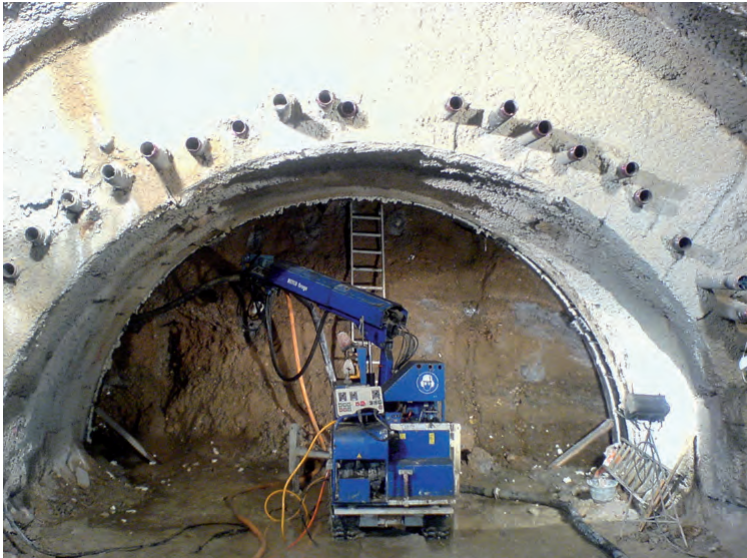
Fig. 28. Perforación de un segundo paraguas.
