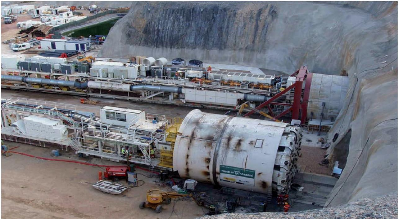
Téngase en cuenta que, en tales casos, la colocación inmediata del revestimiento para que actúe como sostenimiento primario, sustituye con ventaja las fases de ejecución de sostenimientos de tipo pesado que precisan las máquinas abiertas (anillos de hormigón proyectado e, incluso, cerchas).
