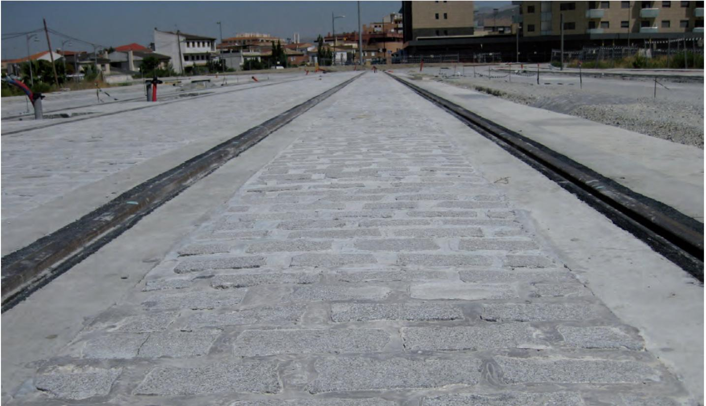
Fig. 18. Vía hormigonada y acabado de adoquines.
