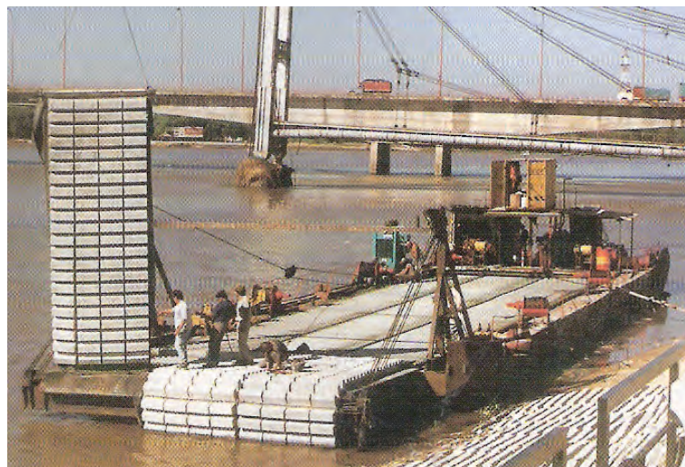
Fig. 19. Colocación de geomantas desde pontona. El peso de las geomantas de la toma es de 500 kg/m 2 .
