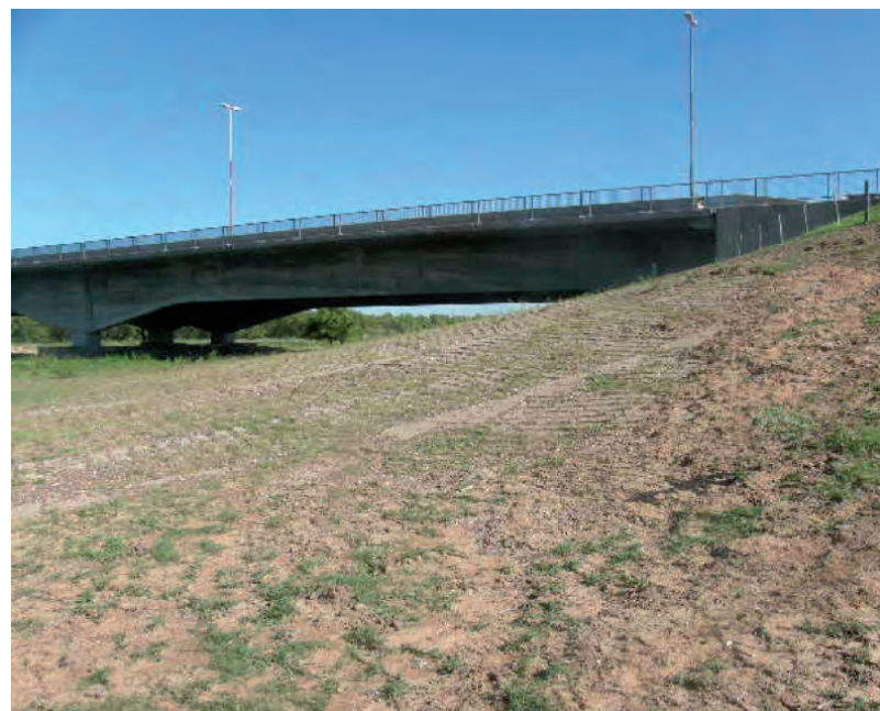
Fig. 17. Protección del estribo de uno de los puentes de la autovía Rosario-Victoria, con mantas cosidas.
