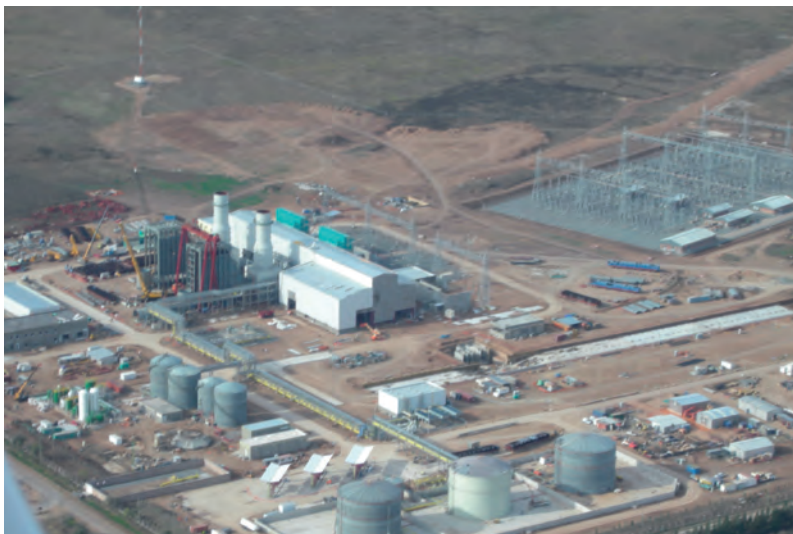
Fig. 3. Vista general de las obras en julio de 2008.
