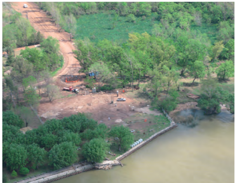
Fig. 10. Defensa actual del balneario anexo a la toma con una pantalla de palos hincados.
