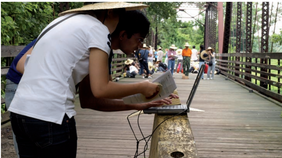
Ingenieros de Corea del Sur y USA durante la captación de señales inalámbricas en un puente de acero de varios vanos. (Foto: Dr. Daisuke Iba).
