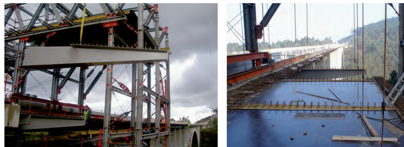
Fig. 8 y 9. Colocación de voladizos metálicos y encofrado de la losa.
