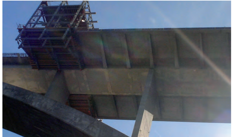
Fig. 10 y 11. Vista inferior del tablero ampliado.
