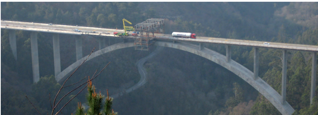
Fig. 12. Vista aérea del tablero en fase de ampliación.
