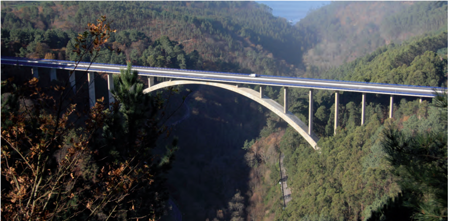
Fig. 13. Vista aérea del tablero ampliado.
