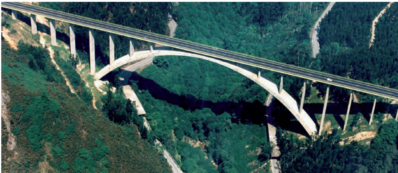
Fig. 1. Viaducto antes de la ampliación.
