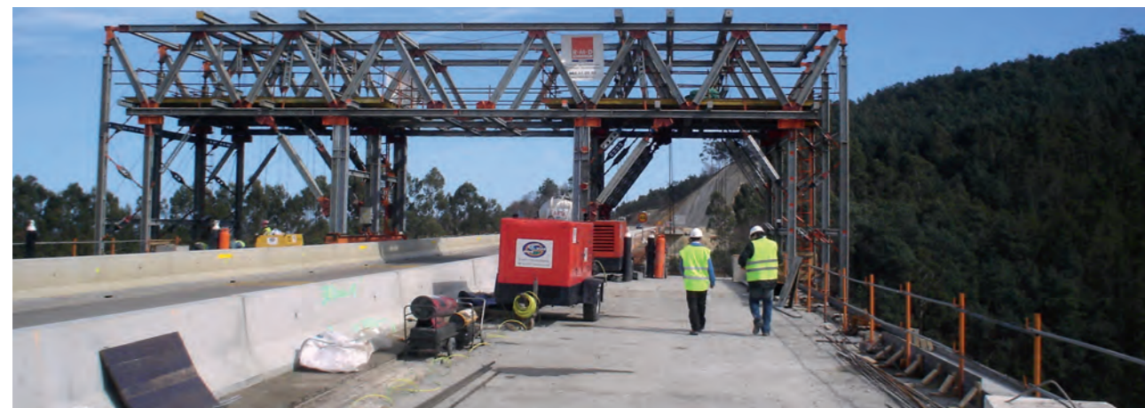
Fig. 7. Carro para colocación de estructura metálica y hormigonado.
