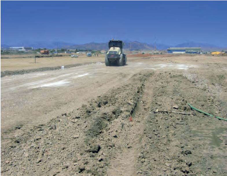
Fig. 11. Nivelación y compactado.
