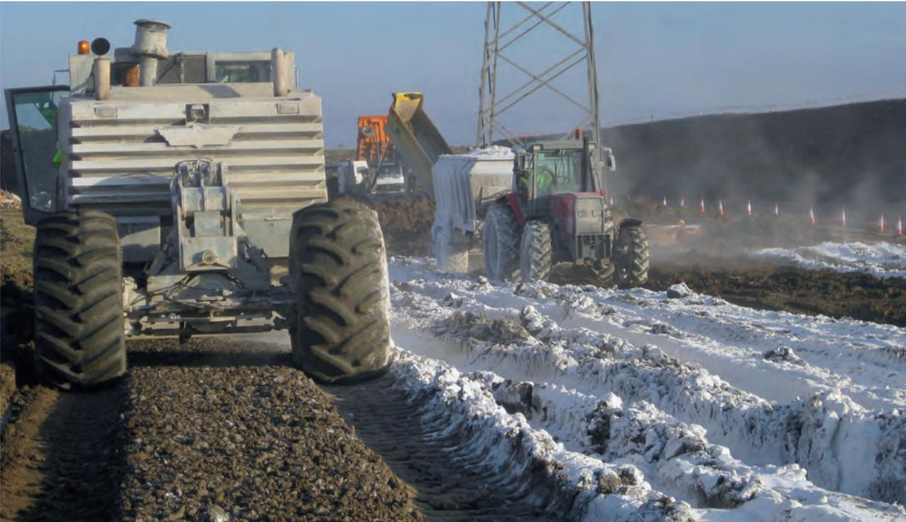
Fig. 16. (Arriba y abajo). Nivelación y compactación.
