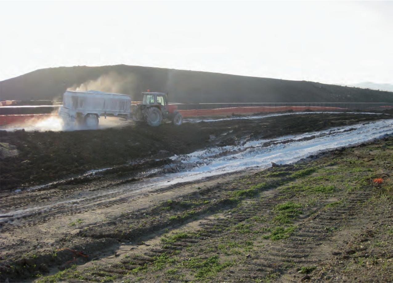
Fig. 15. (Arriba y abajo). Aporte de cal y mezcla con los lodos.
