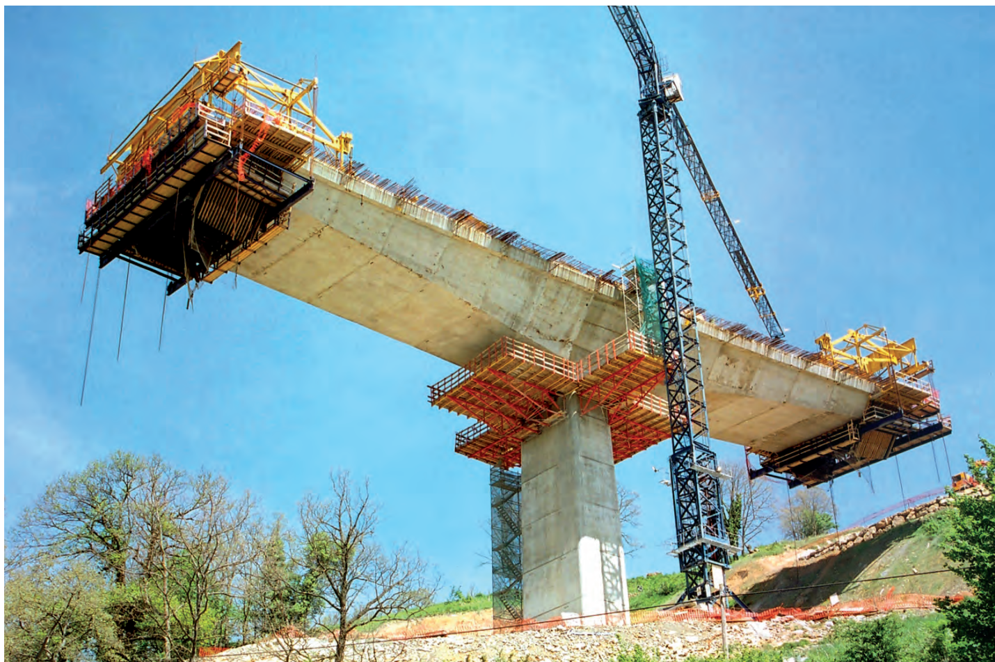
Fig. 10. Avance en voladizo de T de pila P1.
