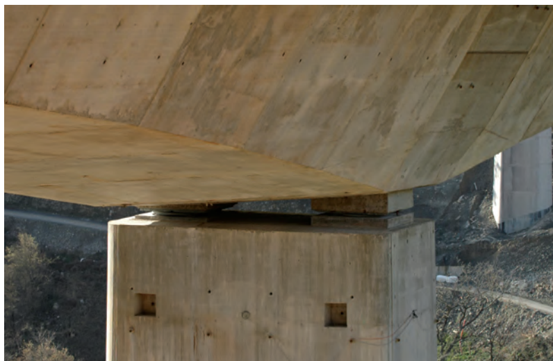
Fig. 7. Detalle del apoyo del tablero sobre la pila.
