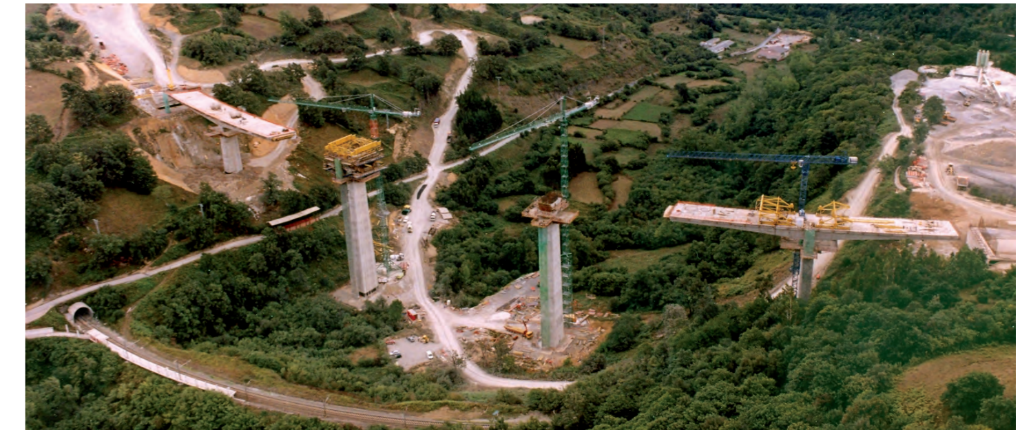
Fig. 11. T de pilas P1 y P4 acabadas. Avance en voladizo en T de pila P2.
