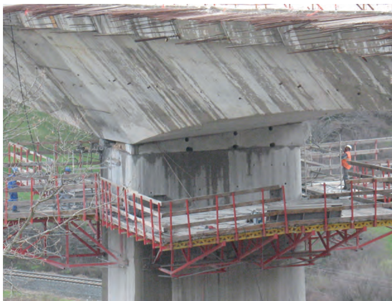
Fig. 6. Corte del empotramiento entre tablero y pila.
