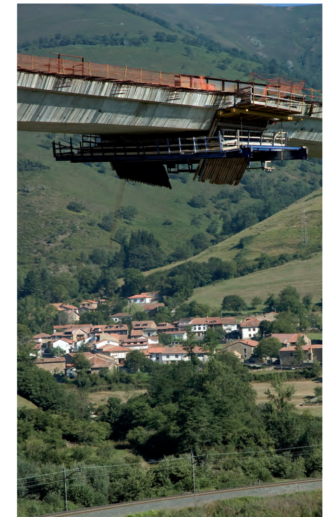
Fig. 11. T de pilas P1 y P4 acabadas. Avance en voladizo en T de pila P2.
