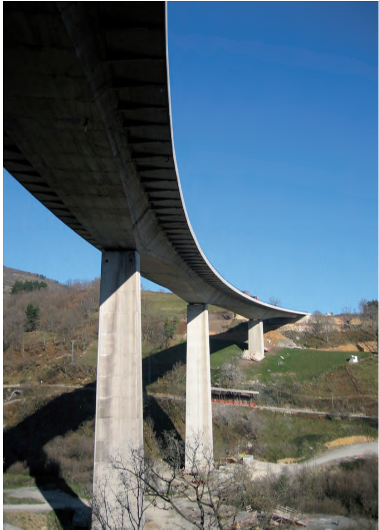
Fig. 2. El viaducto desde la ladera sur.
