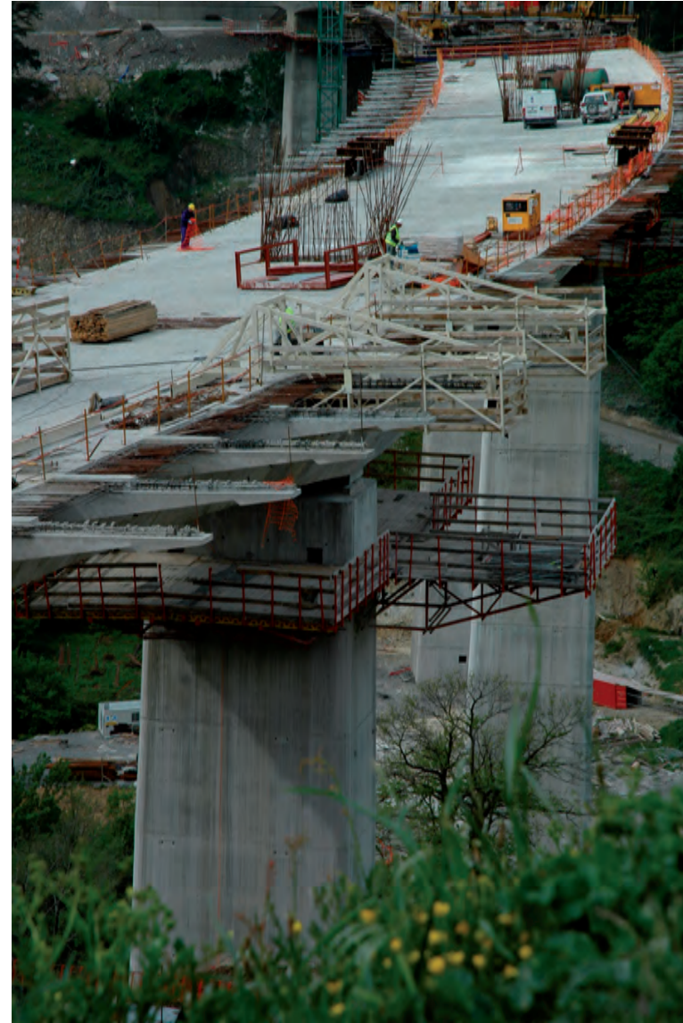
Fig. 13. Construcción de nervios laterales.
