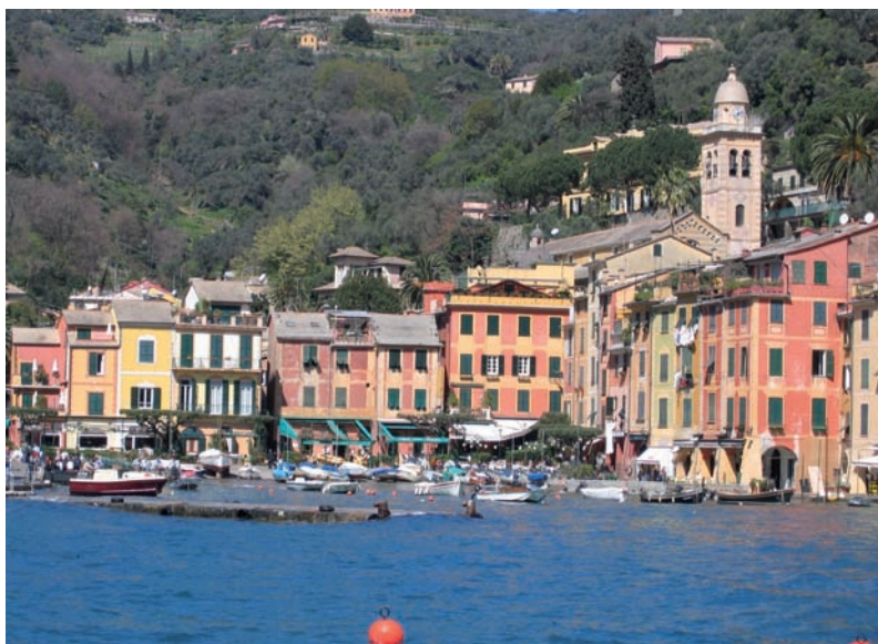
Fig. 10. Otras instalaciones portuarias. Portofino.
