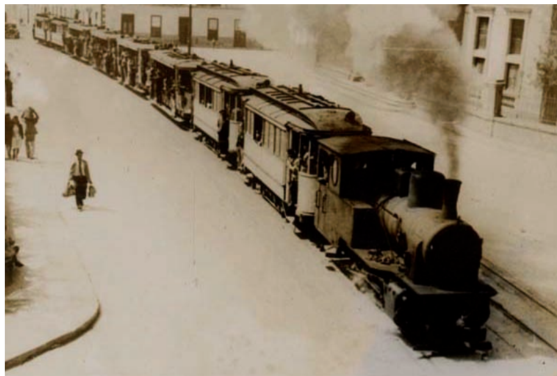
Fig. 11. Tranvía de vapor en Las Palmas de Gran Canaria a comienzos de la década de los cuarenta.
