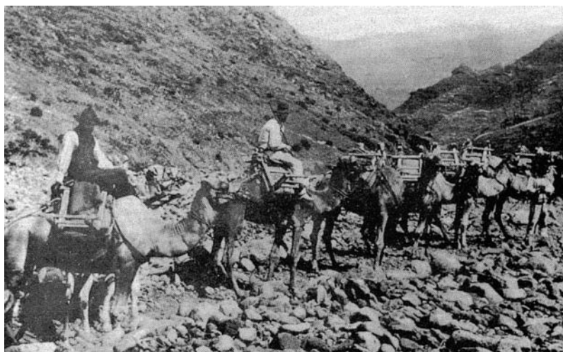
Fig. 2. Caravana de camellos transportando arenas y gravas de barranco para la construcción.
