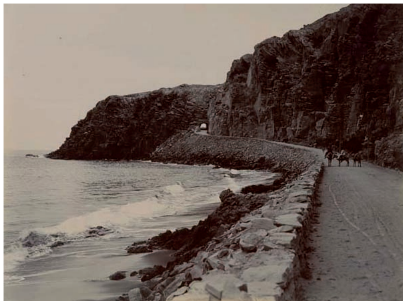
Fig. 5. Arriba, carretera de Telde, en Gran Canaria (1890). Abajo la carretera de Telde en la zona costera de La Laja y túnel de la Marfea hacia 1900.
