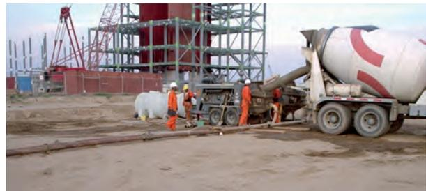
Foto 3. Camión hormiguera y bomba utilizada en el ensayo.
