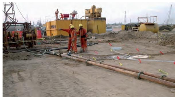
Foto 5. Tuberías de acero y mangueras de gomas utilizadas en el ensayo.
