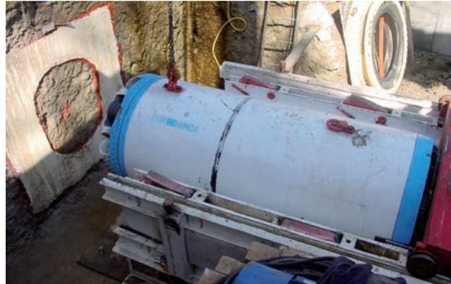
Fig. 5. Emplazamiento de carro de empuje y TBM.
