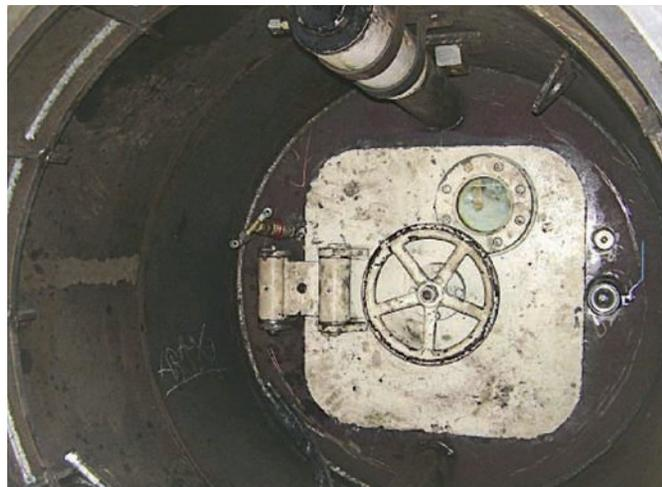
Fig. 7. Compuerta estanca vista desde aguas abajo, y aguas arriba respectivamente.
