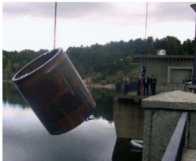
primer mes y medio se acometieron los trabajos de acondicionamiento de caminos, pozo de ataque, montaje de las instalaciones para la perforación, y el suministro de la tubería de hormigón con camisa de chapa para la hinca. Fue el plazo de la fabricación y suministro de la tubería lo que marcó el comienzo de la perforación.
