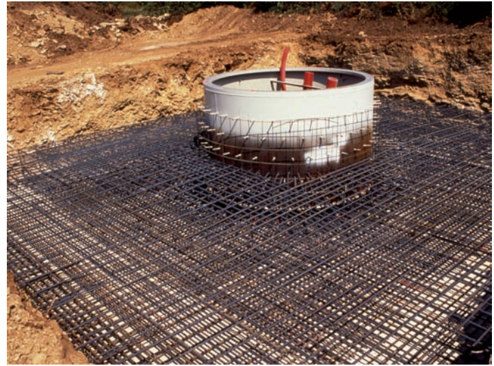
Foto Nº 11. Virola colocada para hormigona/Picture 11. Embedded steel section ready for pouring.
