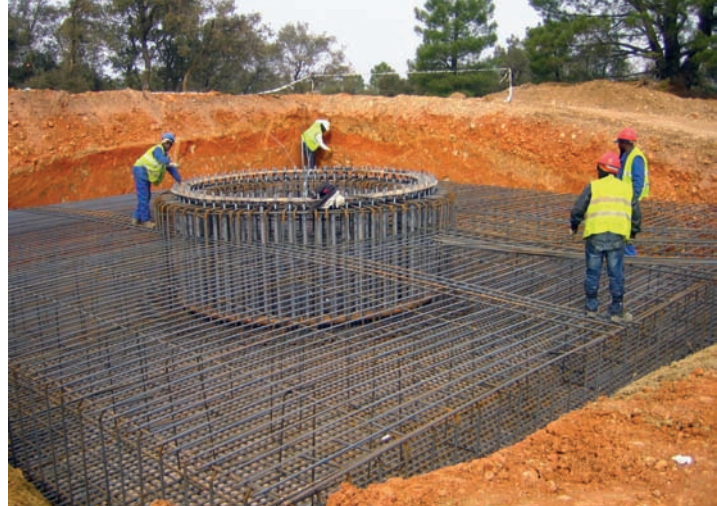
Foto N° 14. Colocando la armadura superior/Picture 14. Placing of upper framework .
