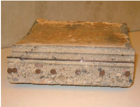
Foto N° 4. Trozo de tubo/Picture 4. Piece of tube.
