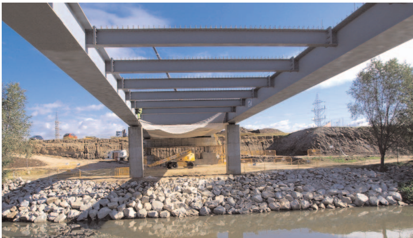
Fig. 28. Vista inferior de las vigas y riostras metálicas de la Pasarela del Manzanares.
