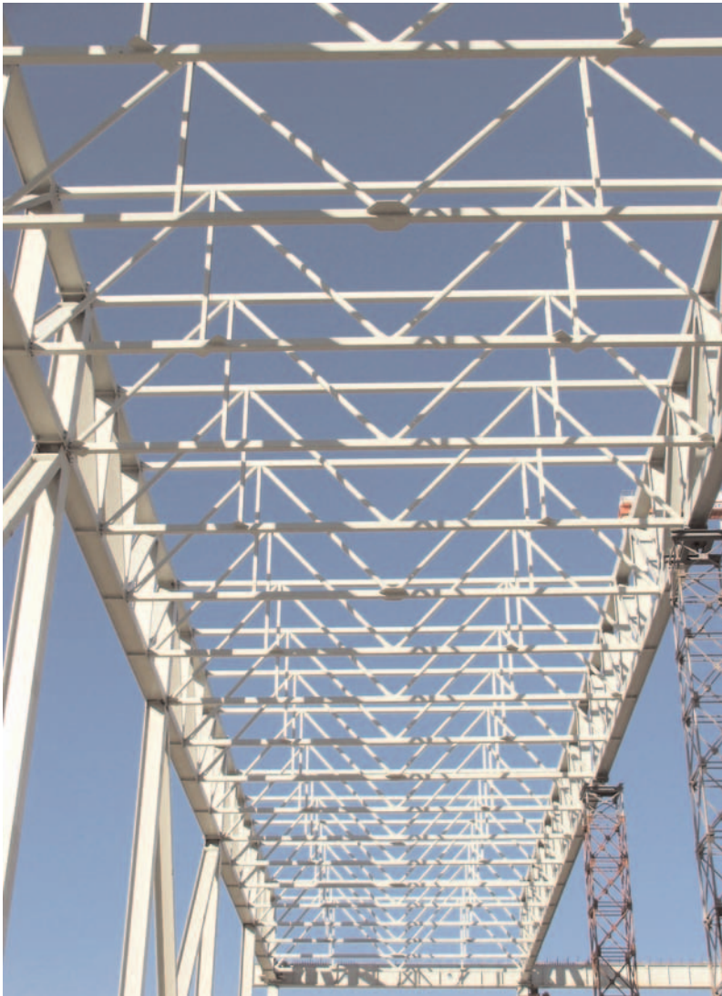
Fig. 9. Cercha tipo de estructura de cubierta.
