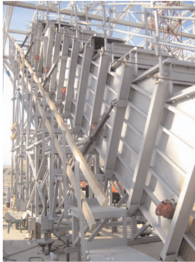
Fig. 3. Armado y encofrado pórticos de gradas.
