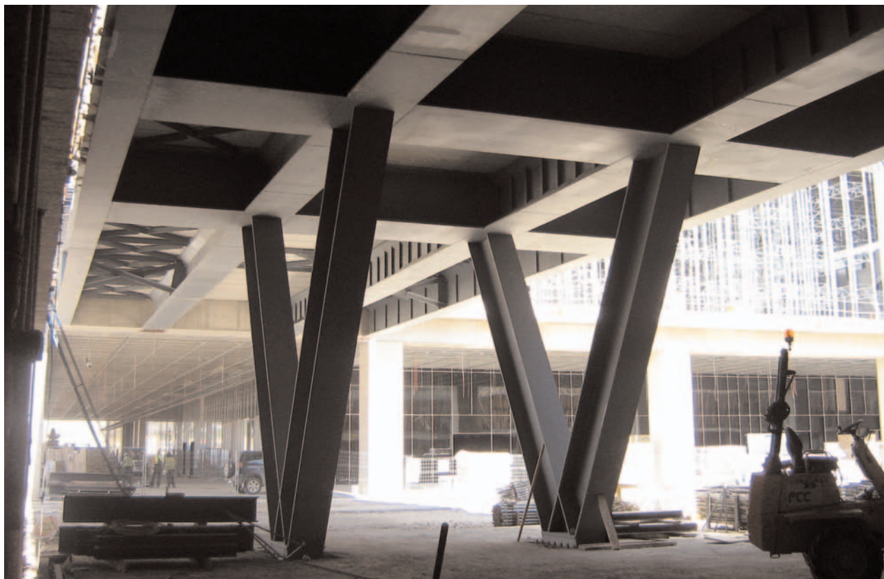
Fig. 27. Vista inferior de la Pasarela de Perales, con las pilas en V.
