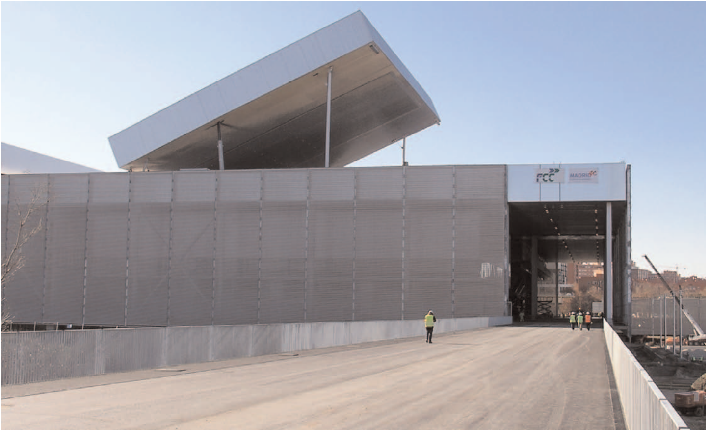
Fig. 13. Apertura de Cubierta 3.
