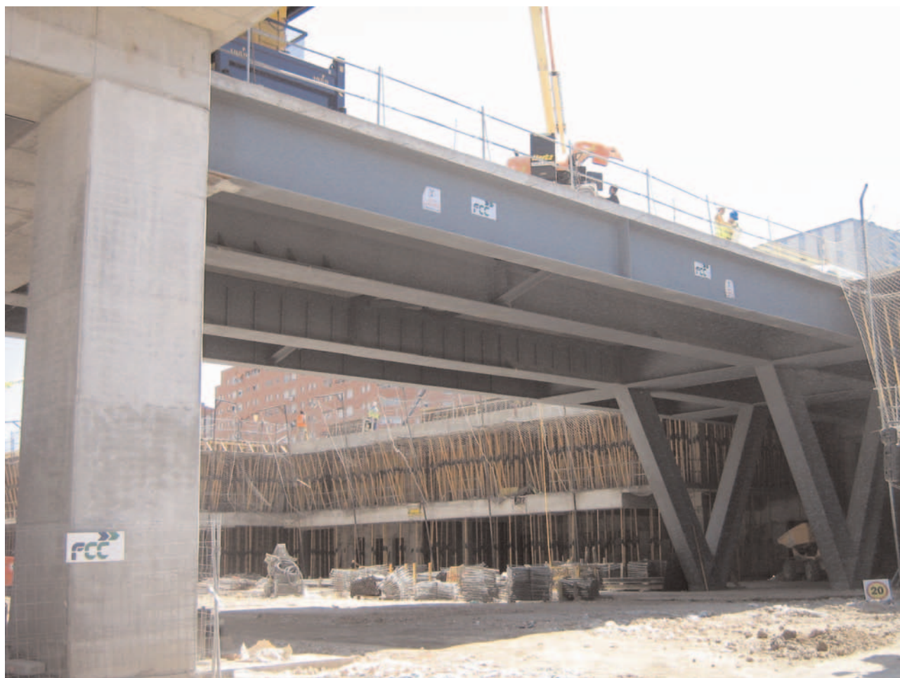
Fig. 26. Vista de la construcción de la Pasarela de Perales.
