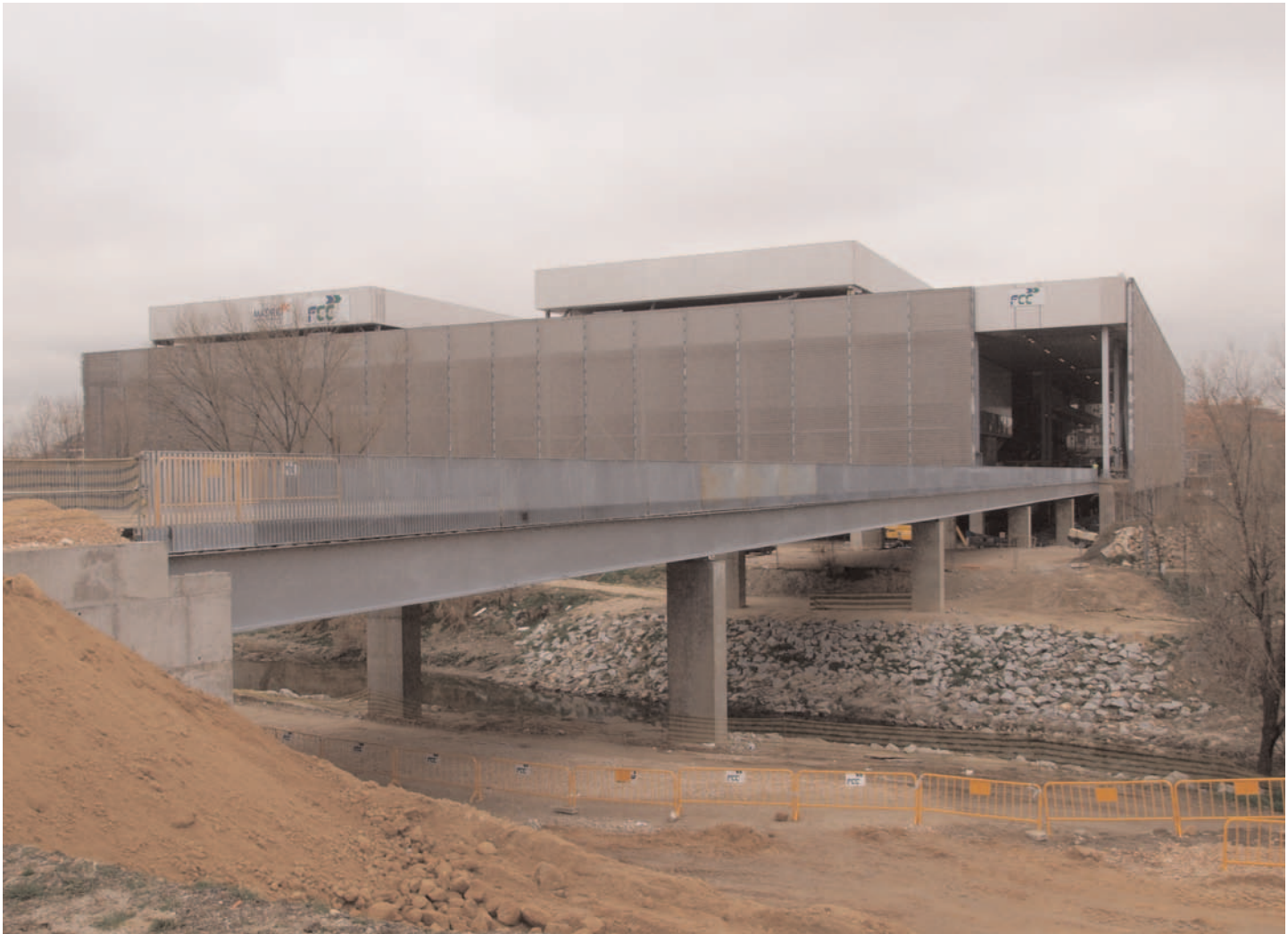
Fig. 29. Vista del acceso a la Caja Mágica por la Pasarela del Manzanares.
