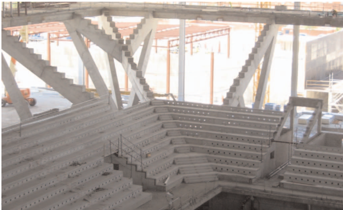
Fig. 6. Vista general del montaje del graderío, pórticos de esquina y losa de Sky-Lounge.
