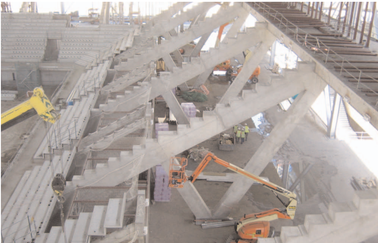
Fig. 4. Graderío este, pórticos tipo.
