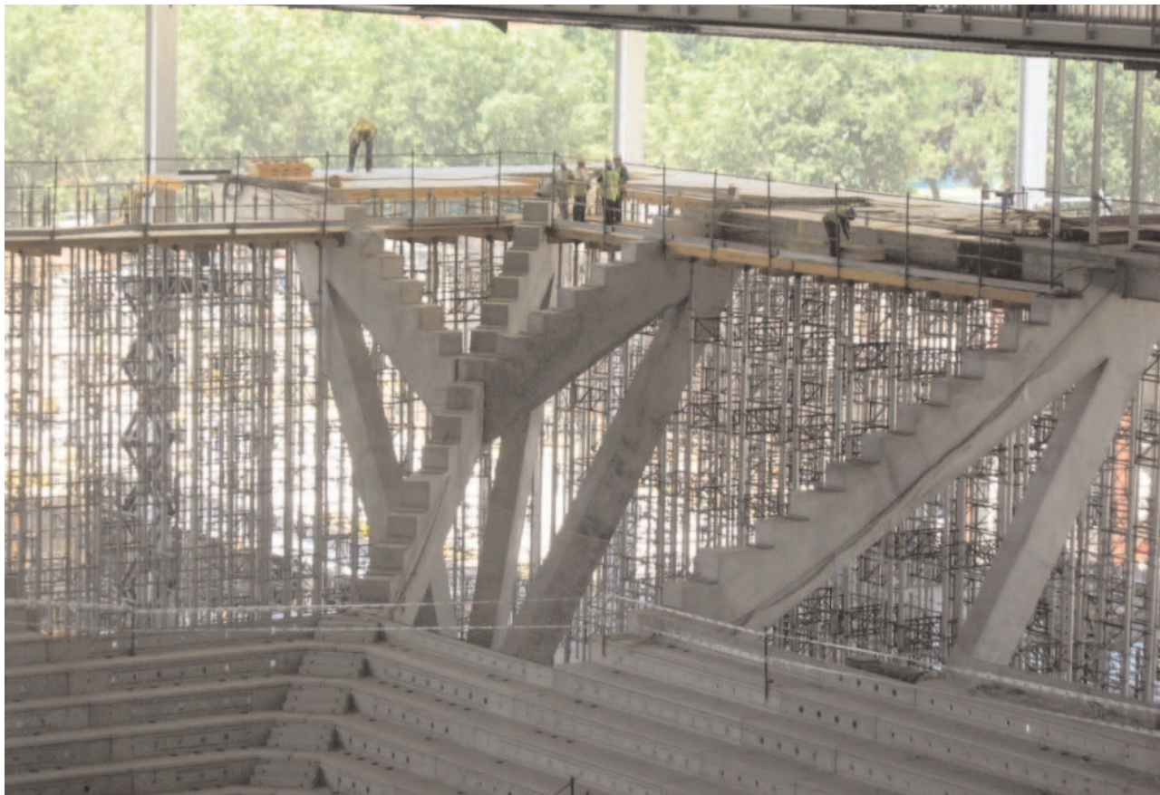
Fig. 7. Cimbra en altura para losa postesada de Sky-Lounge.
