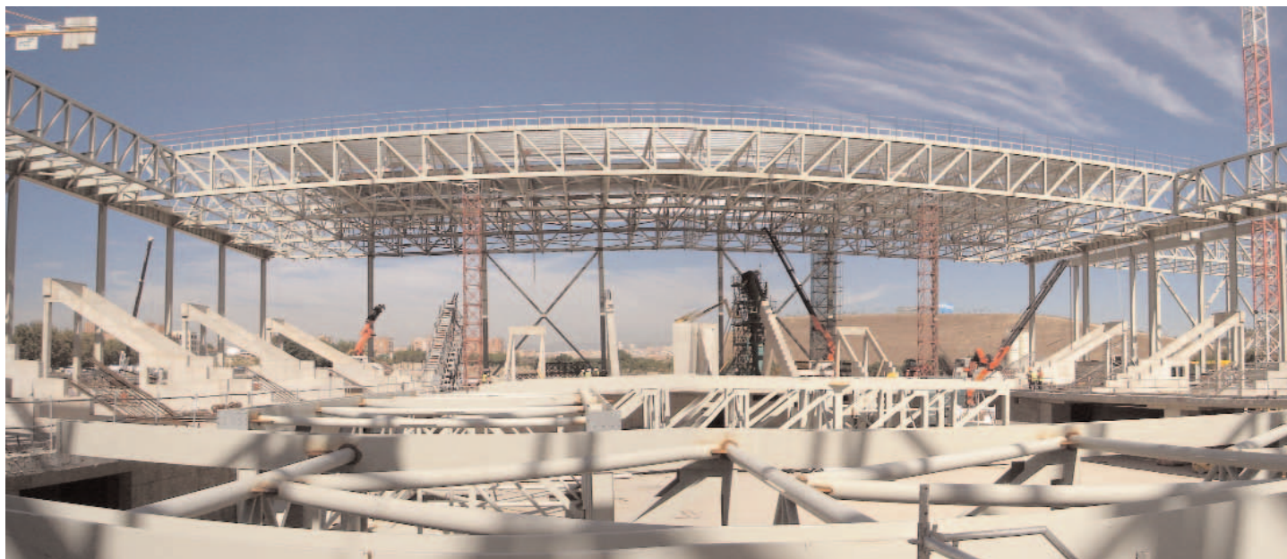
Fig. 10. Vista de la estructura de cubierta.
