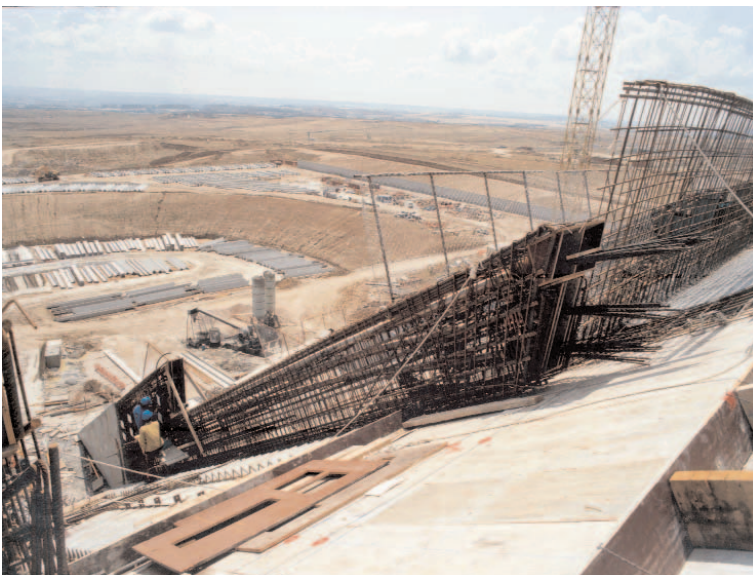
Fig. 9. Ferrallado y colocación de cables en las vigas principales.
