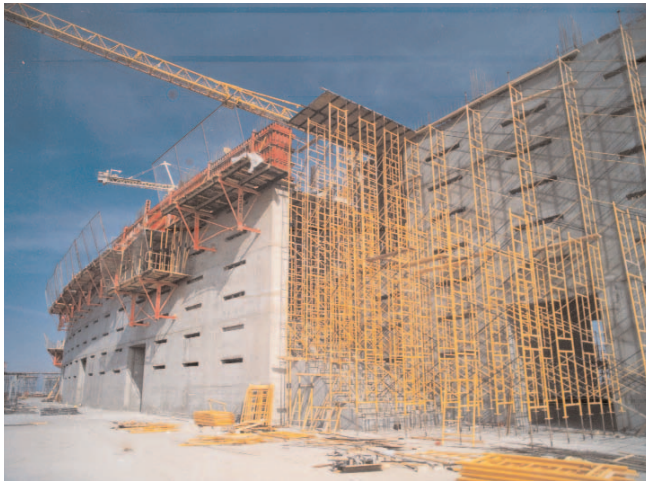
Fig. 8. Ejecución cimbrada de la Gran Tribuna.
