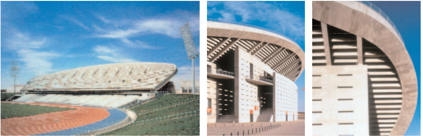
Fig. 3. Vista general frontal y detalles dorsales de la Gran Tribuna del estadio existente.
