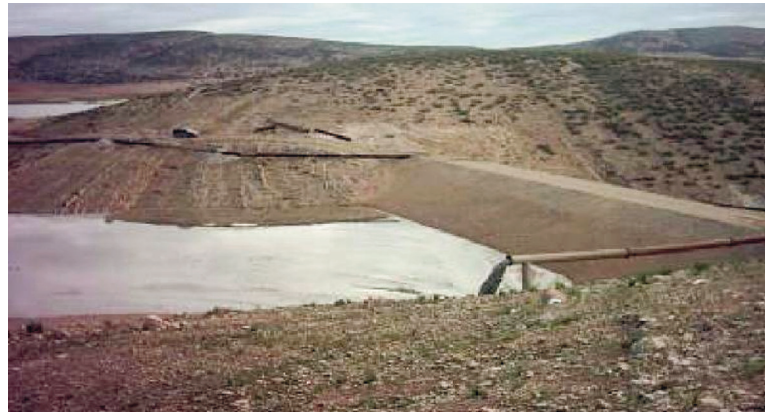
Fig. 8. Embalse de almacenaje de lodos de la presa de Mechra en Marruecos.
