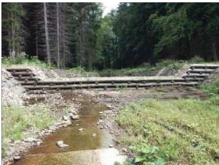
Fig. 14. Dique de retención aguas arriba de la presa de Krímov.
