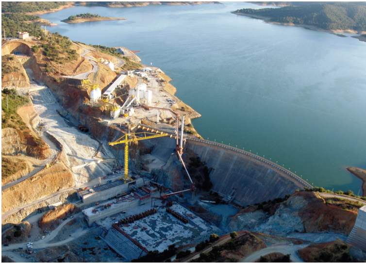
Fig. 3. Recrecimiento de la nueva presa de la Breña.
