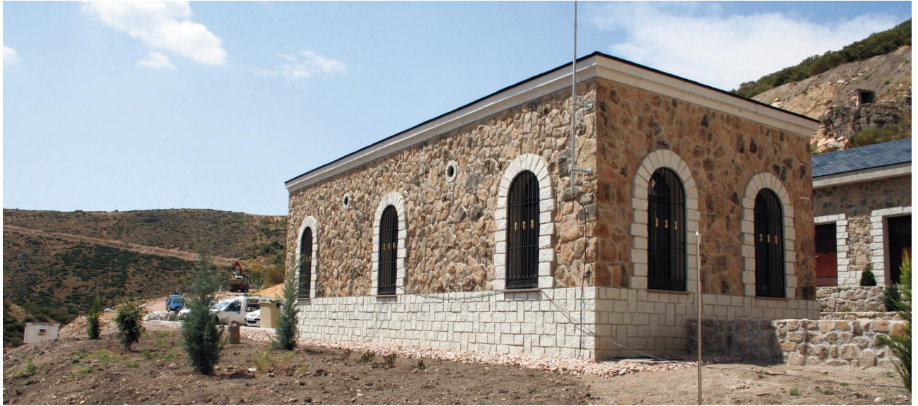
Fig. 8. Edificio de la estación de bombeo, situado a pie de presa.
