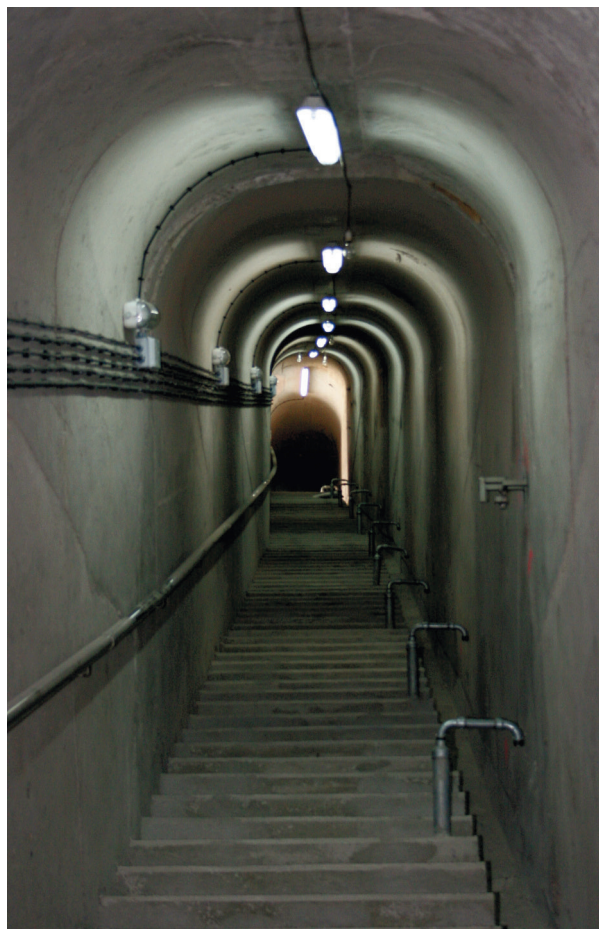
Fig. 7. Vista de la galería perimetral.
