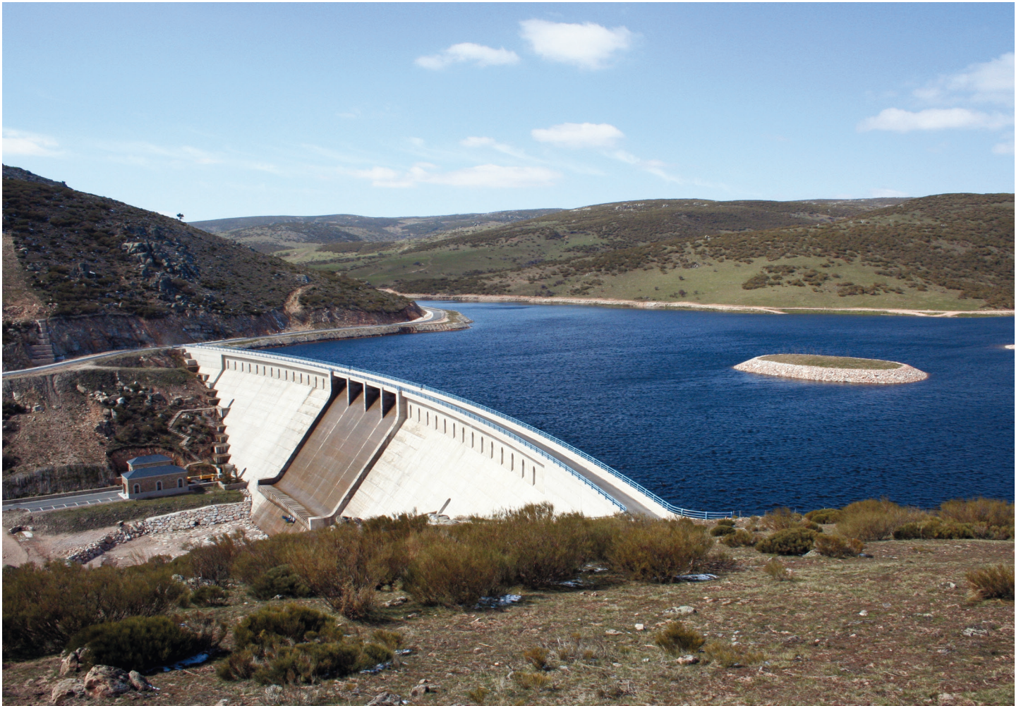
Fig. 4. Vista general de la presa desde el estribo izquierdo.
