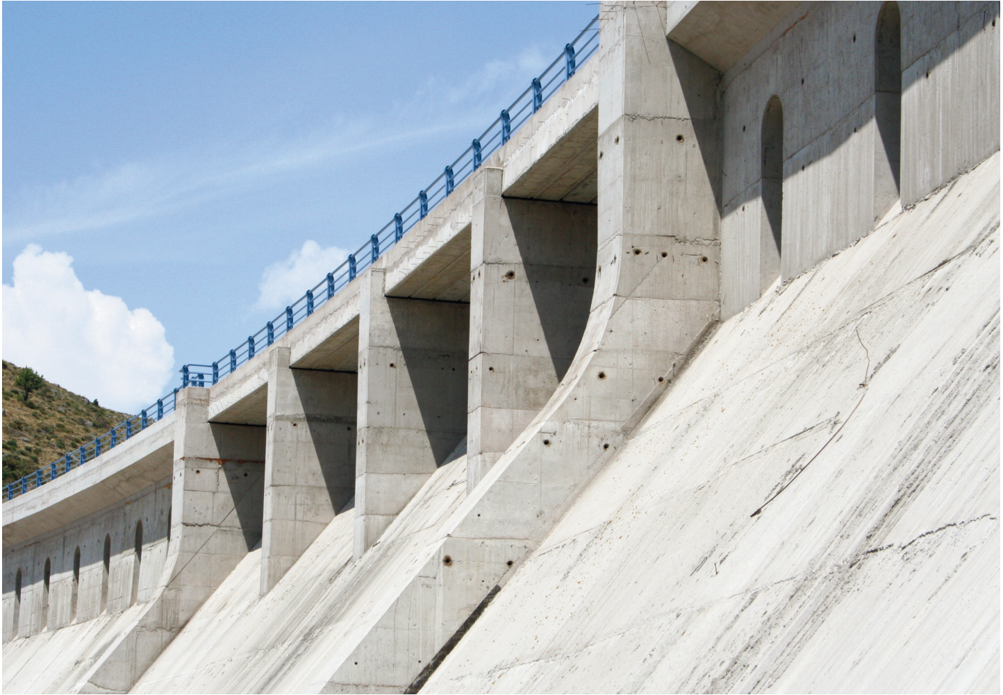
Fig. 5. Detalle de la coronación y del aliviadero vistos desde aguas abajo.
