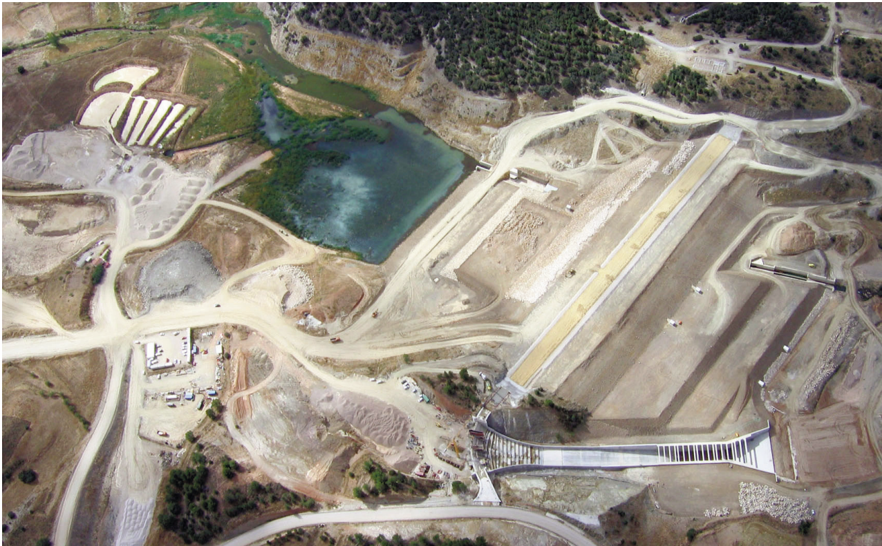
Foto 6. Estado de las obras cerca del final de construcción.
