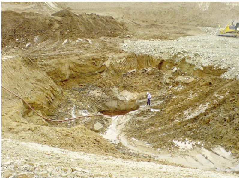
Foto 3. Excavaciones para la cimentación del cuenco del aliviadero.
