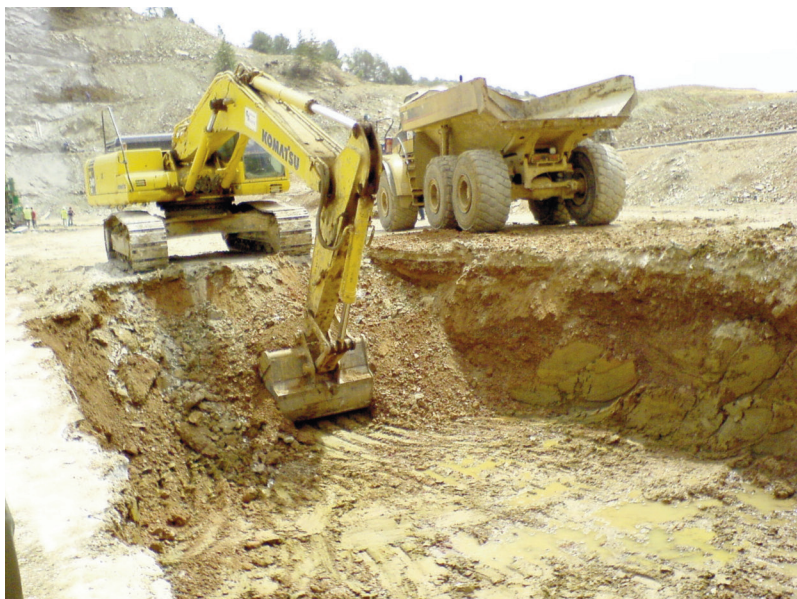
Foto 2. Excavación en el entorno de la pantalla de bentonita-cemento para el apoyo del núcleo.
