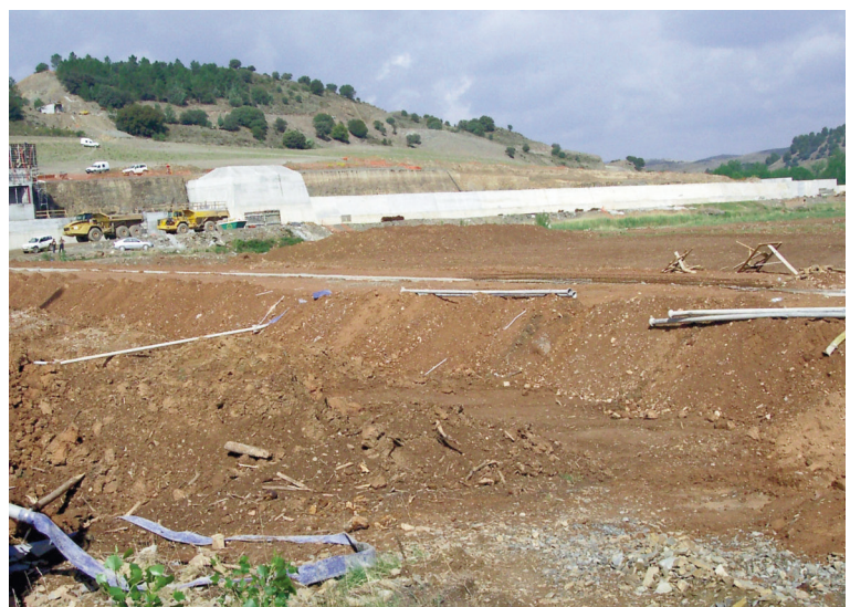
Foto 1. Vista del conducto de desvío, desagües y tomas.
