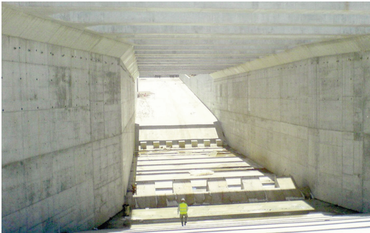
Foto 5. Vista del cuenco de amortiguación construido.
