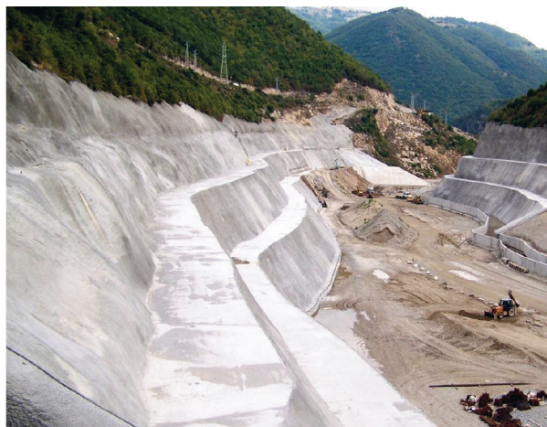
Fig. 34. Sellado en el cauce y taludes del río Gashnya en la conexión con el río Vacha.
