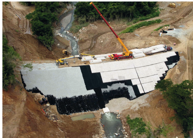
Fig. 25. Ataguía. Manto de bloques y ductos de desvío.
