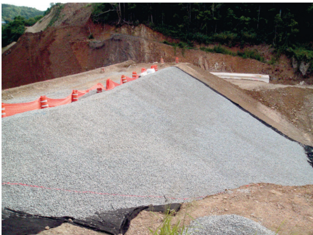
Fig. 24. Ataguía. Lámina y manto de gravas para colocación de bloques.
