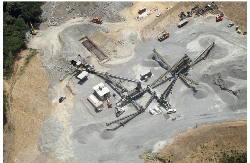
Fig. 27. Vista aérea de la instalación de machaqueo
