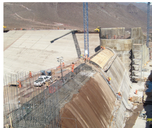
Fig. 14. Construcción del aliviadero (Abril de 2009).
