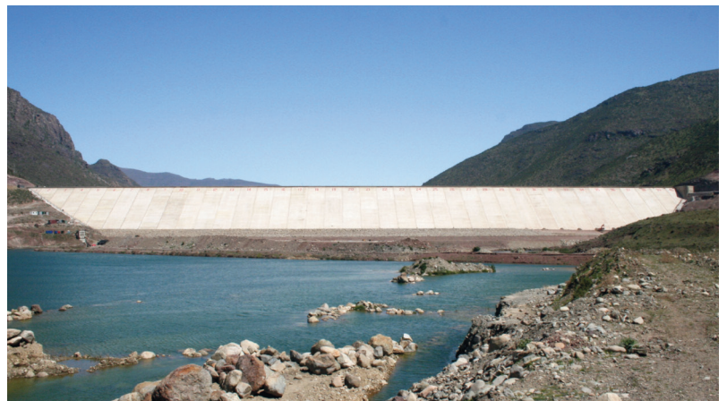
Fig. 2. Vista general de la presa en septiembre de 2009.
