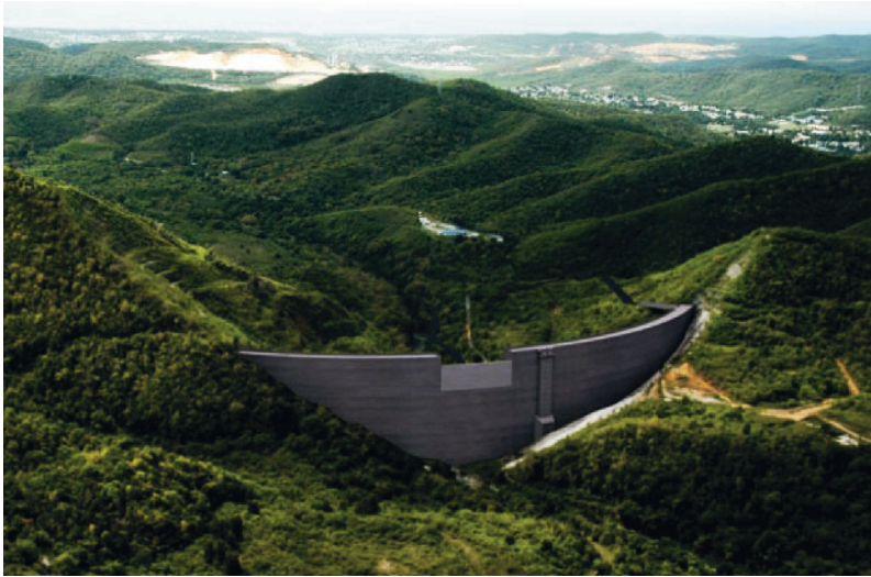
Fig. 17. Zona montañosa donde se ubica la cerrada y el vaso (infografía).
