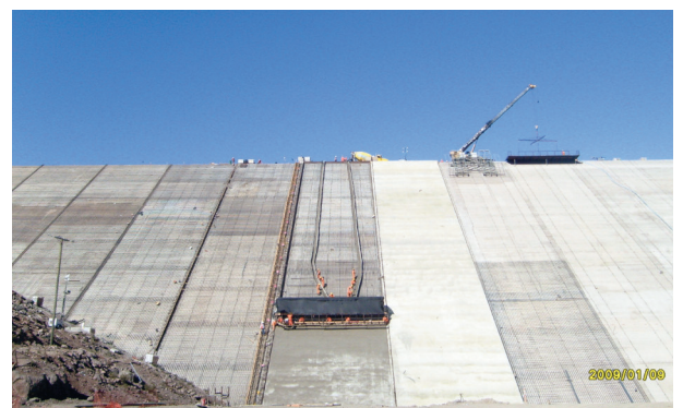
Fig. 7. Hormigonado de la pantalla de hormigón.
