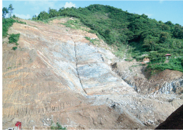
Fig. 23. Excavación ladera izquierda.
