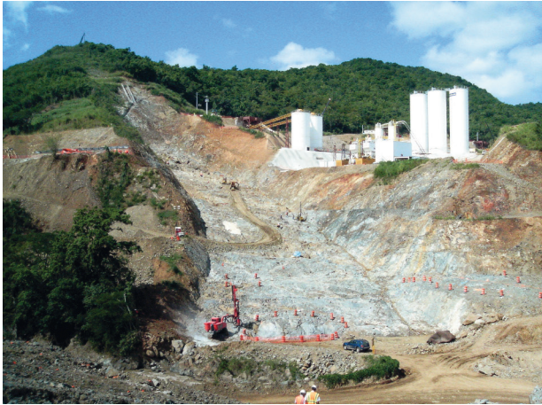
Fig. 22. Excavación ladera derecha .
