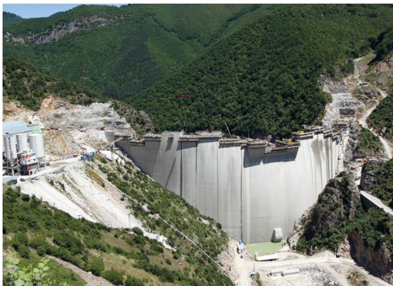
Fig. 30. Vista general de la presa de Tsankov Kamak en septiembre de 2009.
