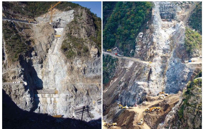
Fig. 40. Excavación en roca de los estribos de la presa.
