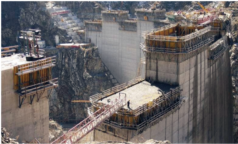
Fig. 37. Bloques y detalle de huecos encofrados para mejora de resistencia a esfuerzo cortante.
