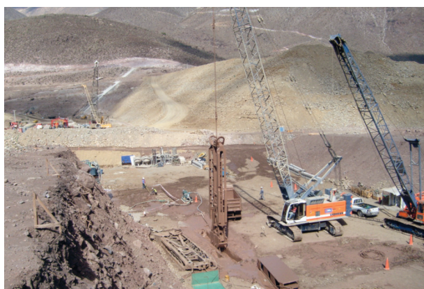
Fig. 12. Ejecución de la pared moldeada en el aluvial y elementos junta entre batches.
