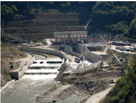
Fig. 33. Toma y Central Hidroeléctrica de Tsankov Kamak.
