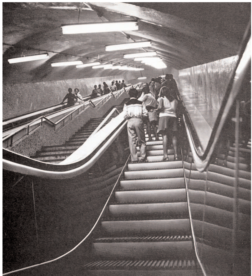
Escaleras mecánicas en Plaza de España (años 60).
