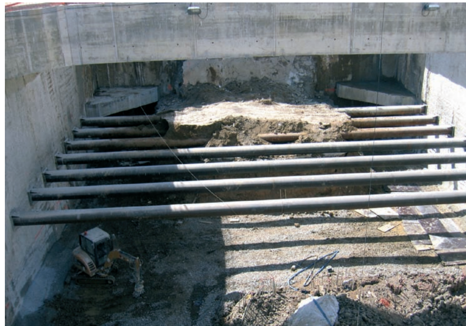
Fig. 8. Acodalamiento provisional metálico ejecutado en la Estación de Guadalhorce.
