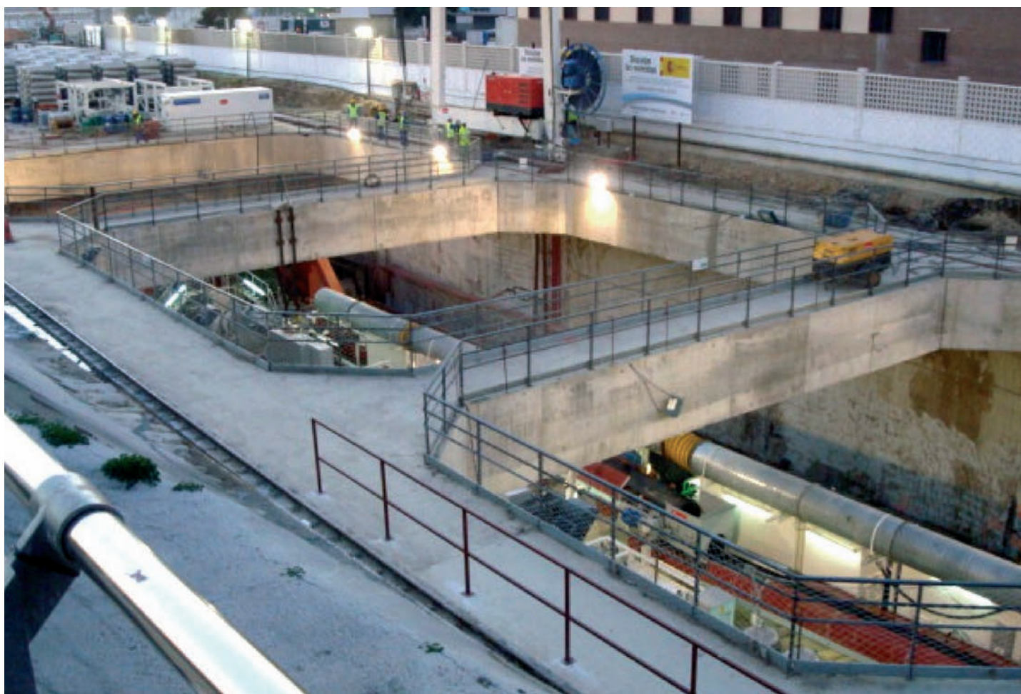
Fig. 6. Pozo de Introducción de la Tuneladora y Estación Guadalhorce.
