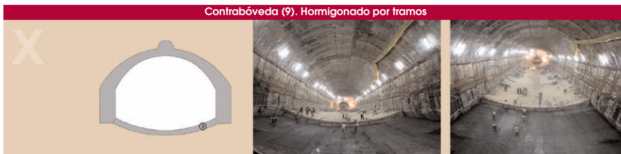
Fig. 20. Ejecución de la contrabóveda.
