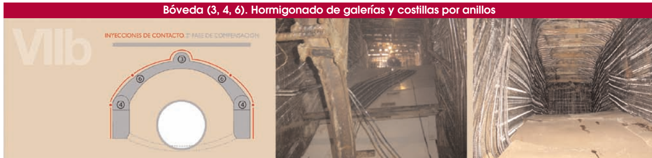
Fig. 17. Vista de una costilla preparada para el hormigonado.
