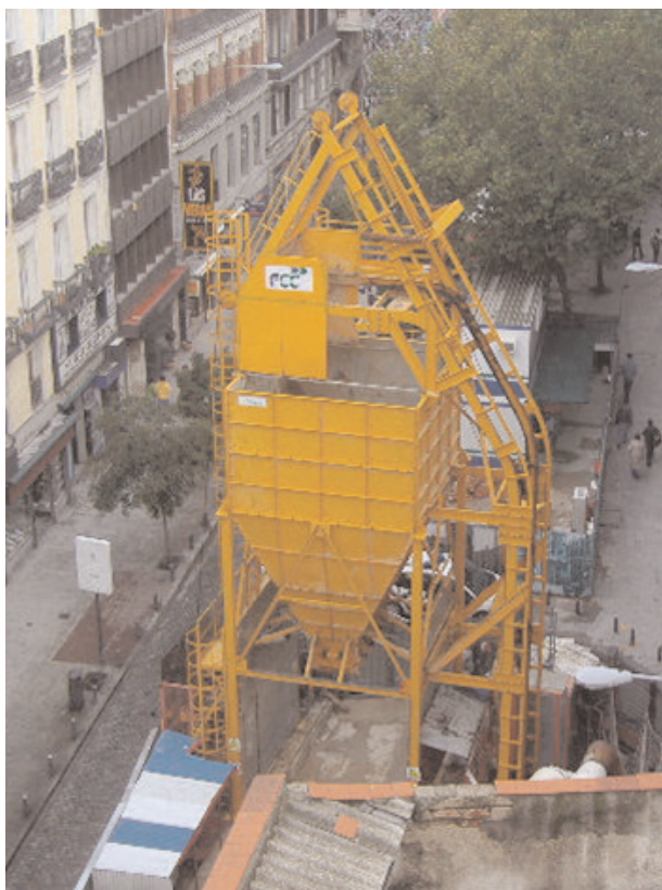
Fig. 25. Pozo de la calle de la Montera.
