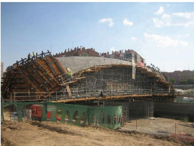
Fig. 27. Desencofrado superior.
