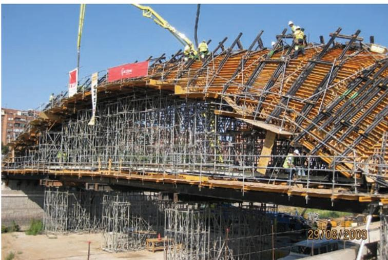
Fig. 14. Estructura pasarela. Doble encofrado de madera.
