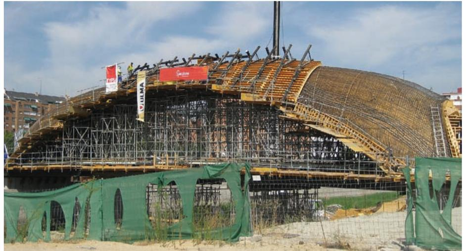
Fig. 2. Encofrado superior.
