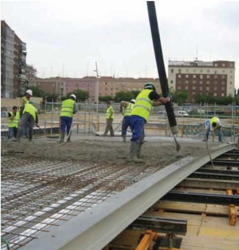
Fig. 1. Hormigonado tablero.
