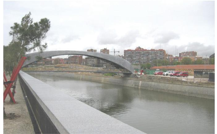
resistencias a la rotura a compresión, en las dos pasarelas se cumplieron con los requerimientos exigidos por la dirección de la obra. Debido a la aplicación de la tecnología del control de madurez, se pudo adelantar el desencofrado y posterior descimbrado de las pasarelas.
