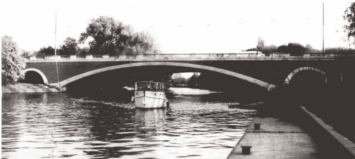
Fig. 1. Puente de Lutyens sobre el Runnymede.
