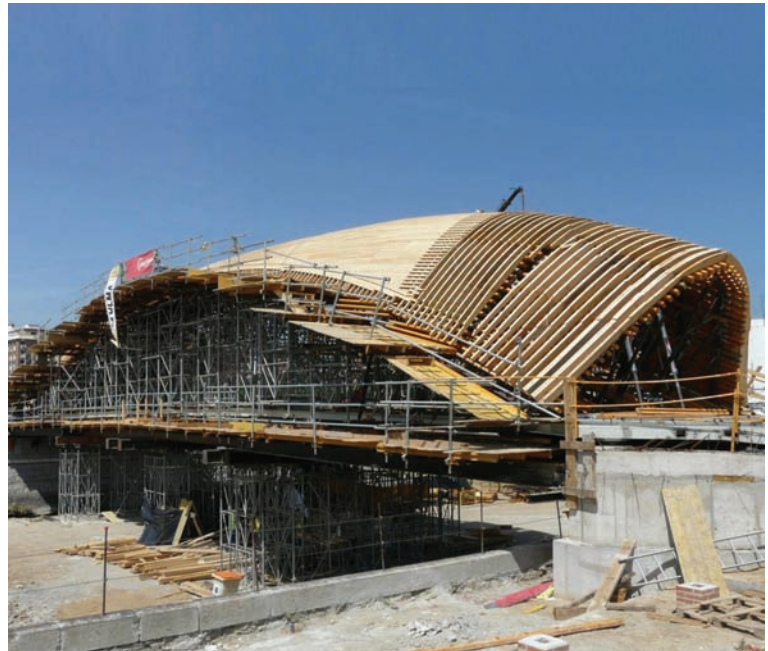
Fig. 13. Detalles del encofrado.
