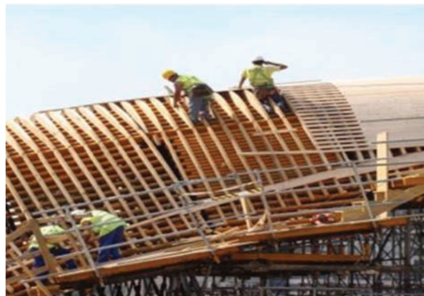
Fig. 13. Detalles del encofrado.
