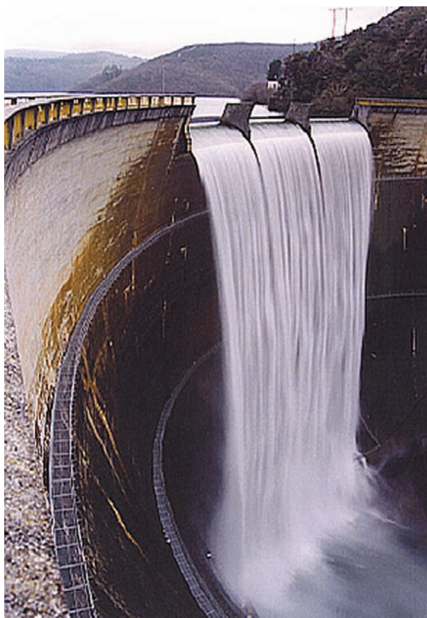
La presa del Eume vertiendo.
