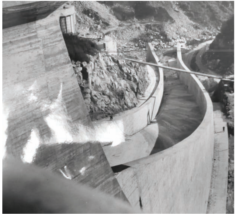
La presa de Belesar durante su construcción.
