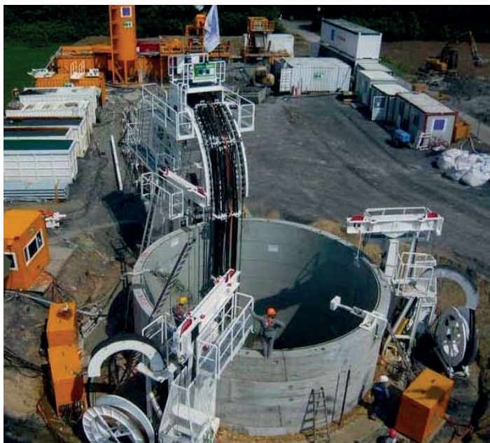
Fig. 8. Instalación de una VSM de última generación/Installation of a latest generation VSM.
