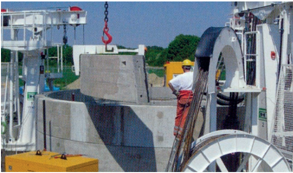
Fig. 11. Colocación de dovelas de un nuevo anillo con aparejos auxiliares para mantenerlas horizontales/Placement of dowels of a new ring with auxiliary apparatus to keep them horizontal.
