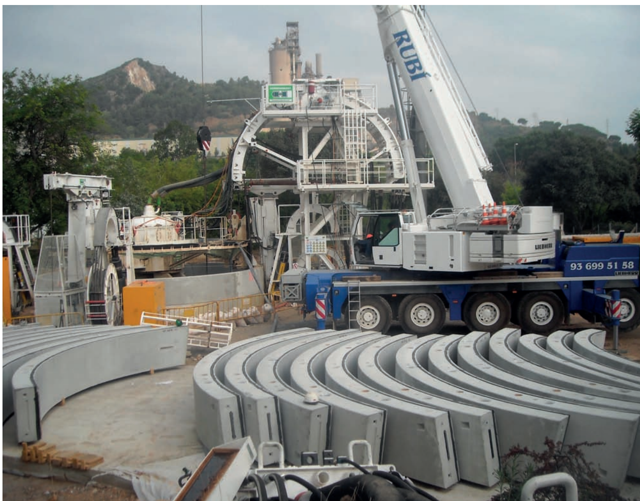
Fig. 8. Instalación de una VSM de última generación/Installation of a latest generation VSM.
