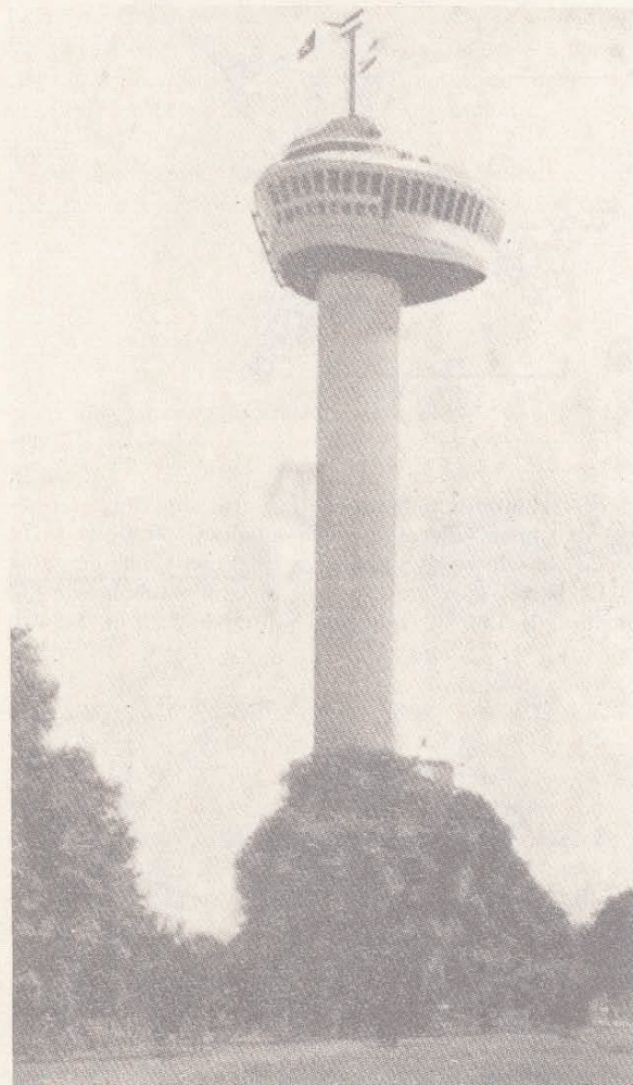
Fig. 1.ª — Vista general de la torre "Euromast".
