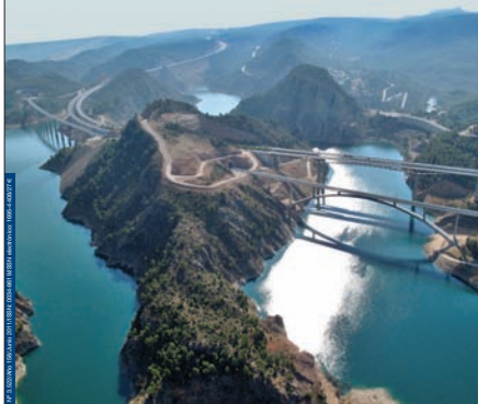
Foto: Viaductos sobre el embalse de Contreras.
