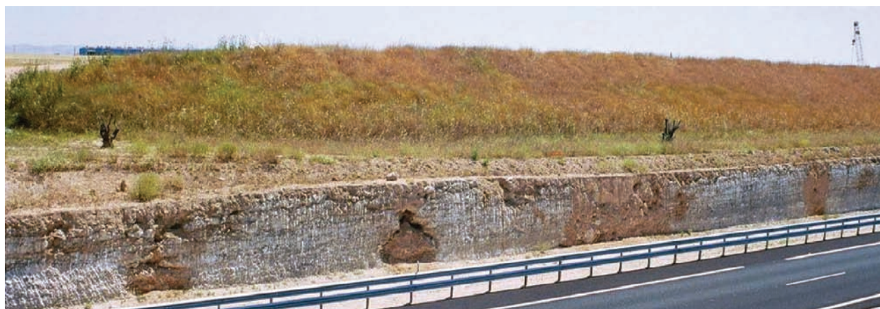
Fig. 6. Huecos kársticos rellenos de arcillas de descalcificación en Aranjuez.
