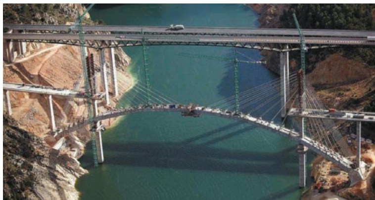
Fig. 11. Puente arco del Embalse de Contreras, en construcción.
