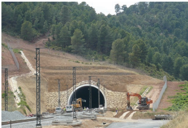
Túnel de la Umbría de los Molinos/ Umbría de los Molinos Tunnel.
