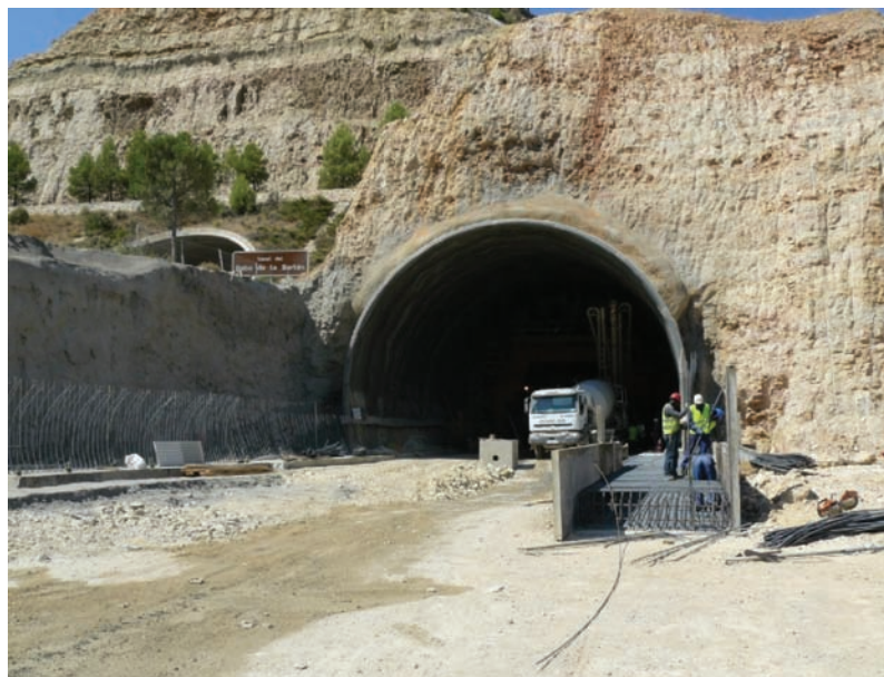
Túnel del Rabo de la Sartén/ Rabo de la Sartén Tunnel.
