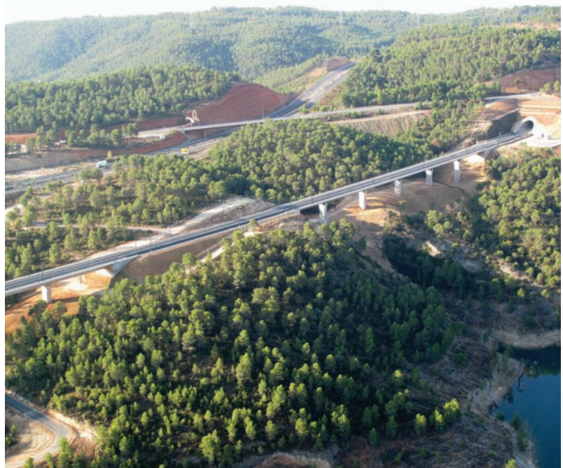
Viaducto de Cuesta Negra./ Cuesta Negra Viaduct.
