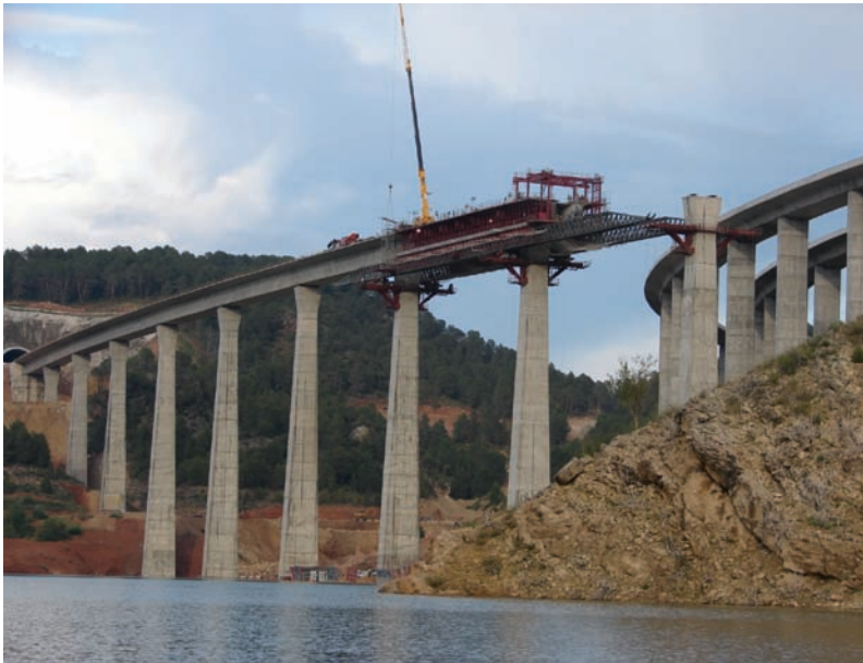
Viaducto del Istmo/ Istmo Viaduct.
