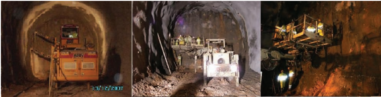
Fig. 4. Perforación y carga de voladura a sección completa. Sostenimiento III.
