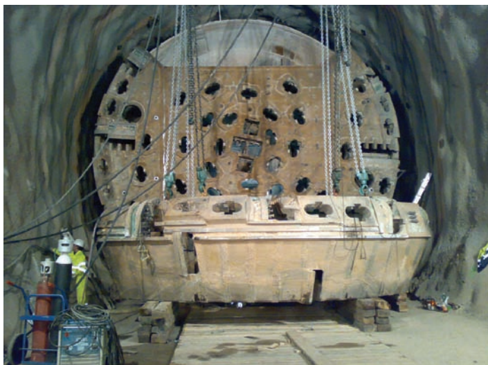
Izquierda, Fig. 9. Desmontaje del primer pétalo de la cabeza de corte. A la derecha, Fig. 10. Detalle de volteo del accionamiento principal.
