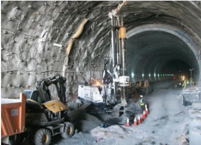
Foto 11. Ejecución de pilotes en la zona con riesgo de sufrir problemas de lixiviación.
