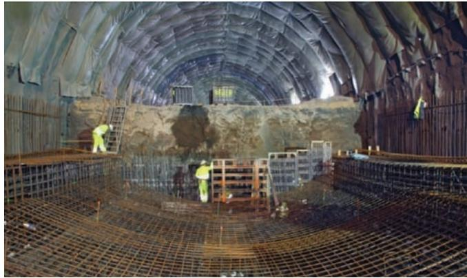
Fotos 5, 6, 7 y 8. Detalles del proceso constructivo en la zona de arcillas en el que se observa la excavación de la destroza, el armado de la contrabóveda y las zapatas, el carro de revestimiento y el túnel acabado.
