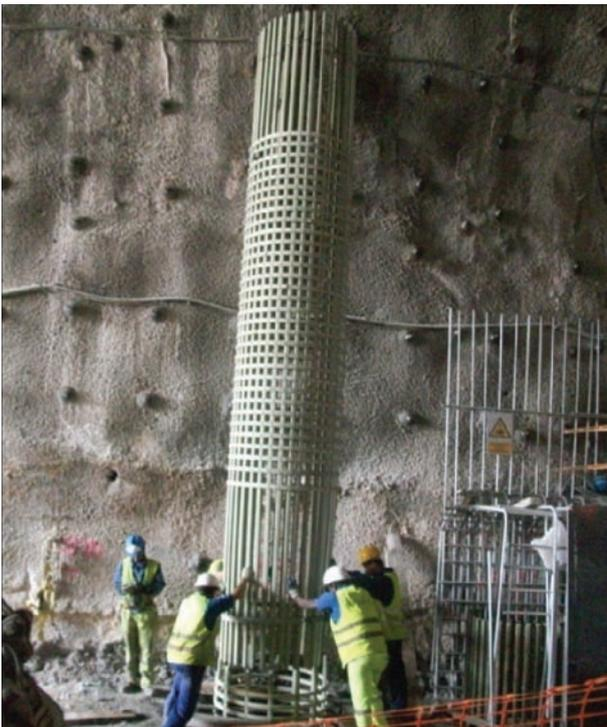
Foto 12: Introducción de un tramo de armadura de pilote, con bandas de fibra de vidrio.
