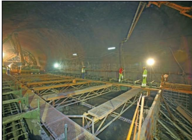
Fotos 9 y 10. Detalles del proceso de hormigonado de la contrabóveda y zapatas conjuntamente.
