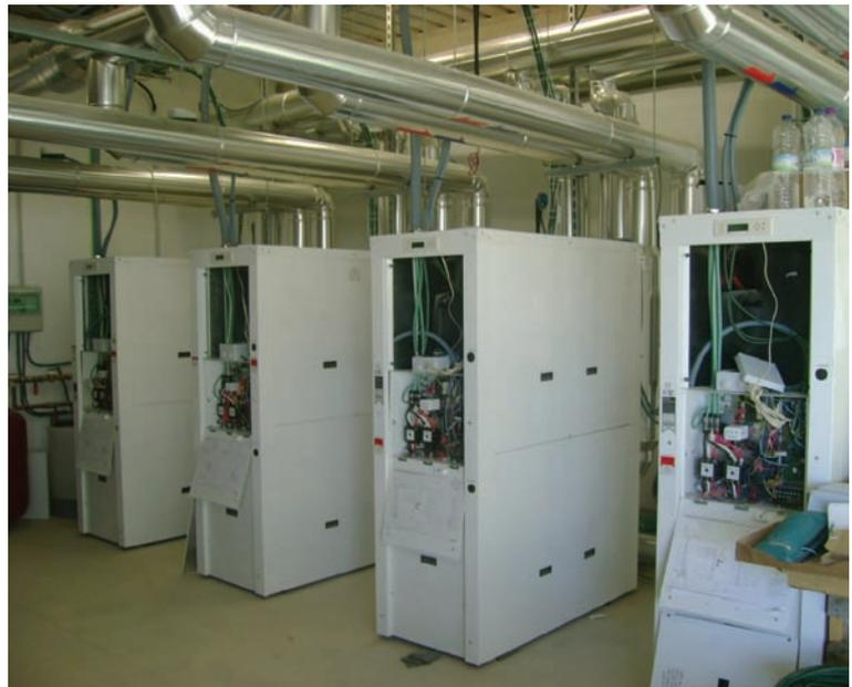
Foto 5. Bombas de climatización instaladas.
