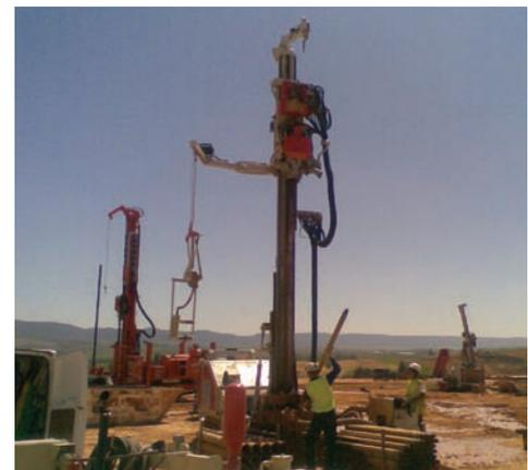
Foto 3 y 4. Perforaciones de los pozos del campo geotérmico.
